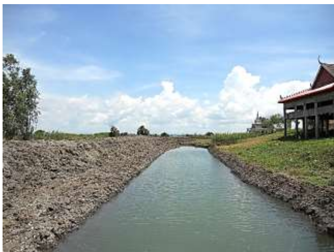
Fossés et remblais en contrebas du vatt Sun Sumālai, village de Bhmaṃ Pūrī, dit Braek Phdol, Tākaev, 23/7/2016, ©marie aberdam
