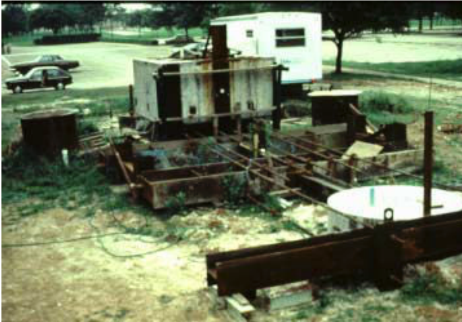
figure 1 - 18 : Photographie du site test de l'Université de Houston.
