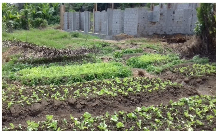
Photo 52: maison en construction sur un terrain initialement occupé par les activités agricoles à Bingerville (Source : Zana, 2015)
