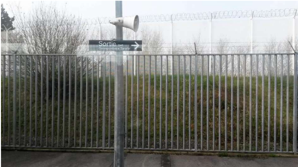
Photographie 7 : Barrières et barbelés sur les quais de l'Eurostar avant le tunnel sous la Manche
