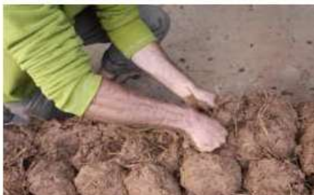
Figure 2-6 Mélange terre fibre pour la bauge
