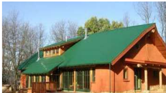
Figure 2-7: Maison individuelle en bauge en Californie
