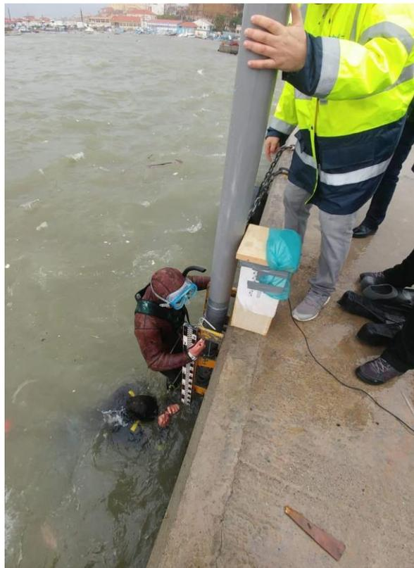
Figure 28 : Installation de l'échelle de marée rotative au port de Tamentfoust
