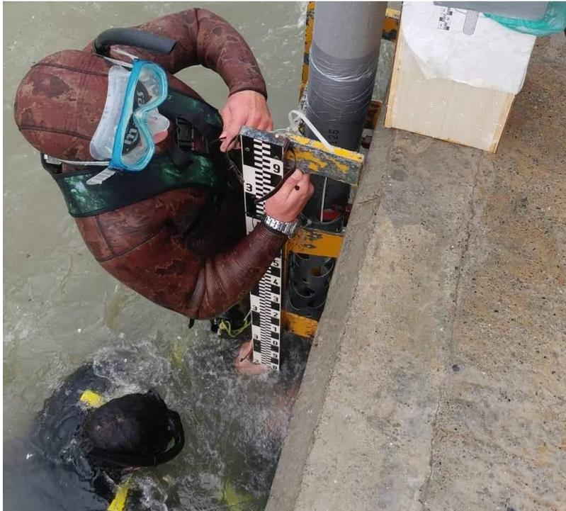
Figure 22 : Installation de l'échelle de marée au port de Tamentfoust
