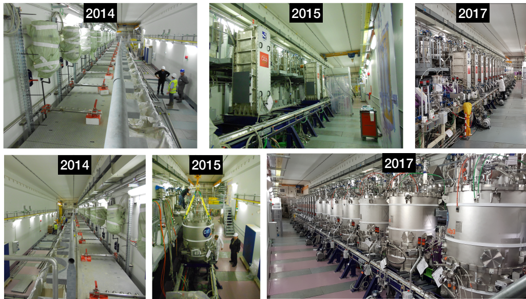
Figure 3.12 – Photographies du LINAC entre 2014 et 2017 montrant la mise en place graduelle des différents éléments qui le composent.
