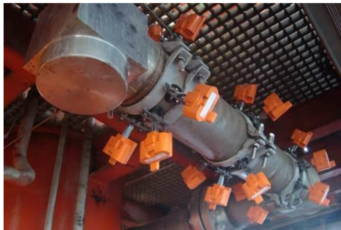
FIGURE 2.2 – Système SHM de Pemarsense
