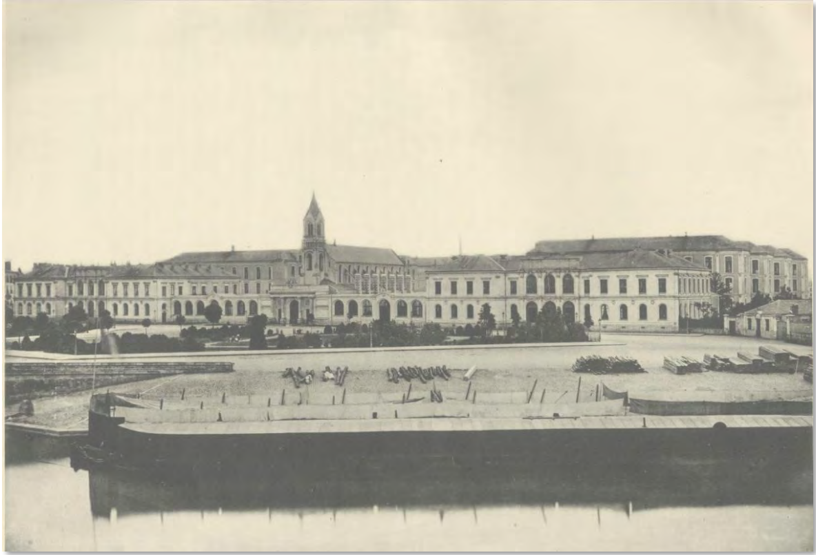
Figure 4 : Photographie de l'École de Plein Exercice de Médecine et de Pharmacie de Nantes, à droite de l'entrée principale de l'Hôtel-Dieu et de sa chapelle 6
