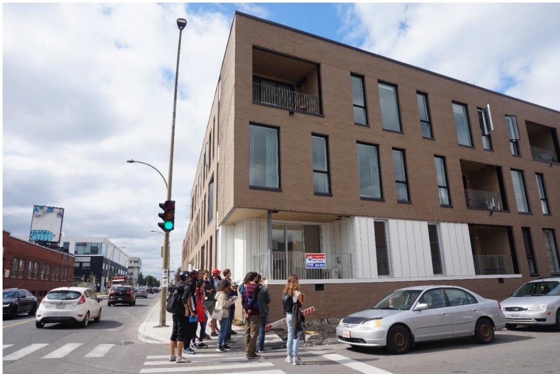
Figure 90 - Deux projets de condominiums sur l'avenue Beaumont à Parc-Extension
