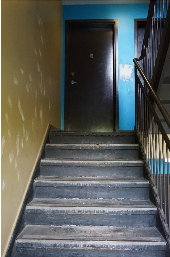
Figure 56 - Le couloir d'immeuble de Fanta
