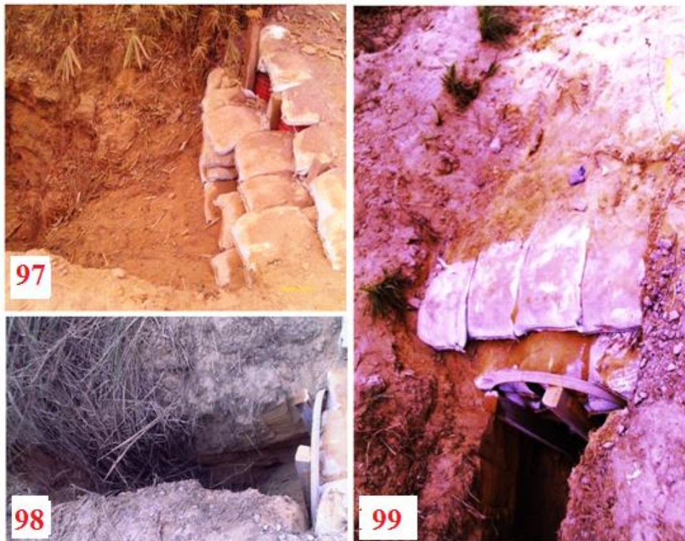
Photos 97, 98 et 99 : Digue de sacs remplis de terres, pour stabiliser les ravinements longitudinaux vers Linzolo.
