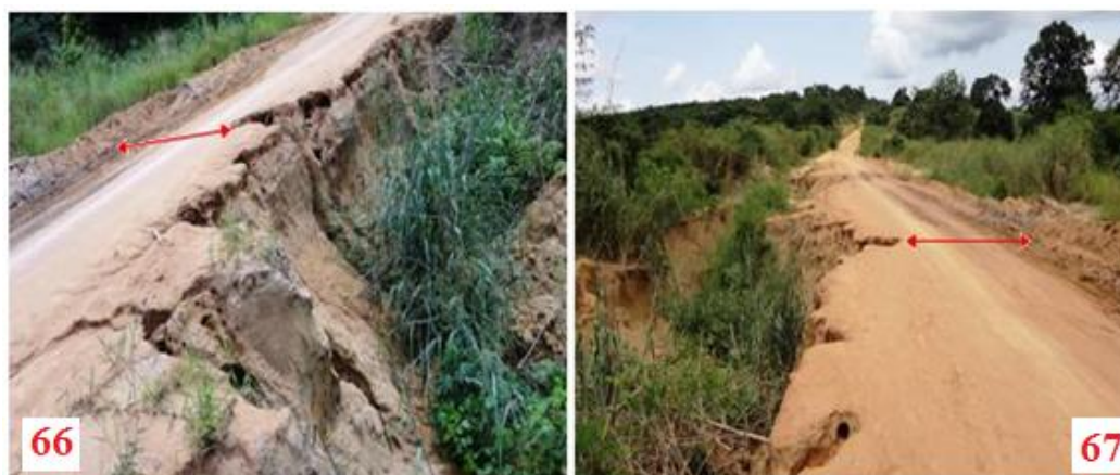
Photos 66 et 67 : Situation évolutive de rétrécissement et de coupure de la piste de Linzolo, au niveau du village Touboula entre 2013 et 2014.
