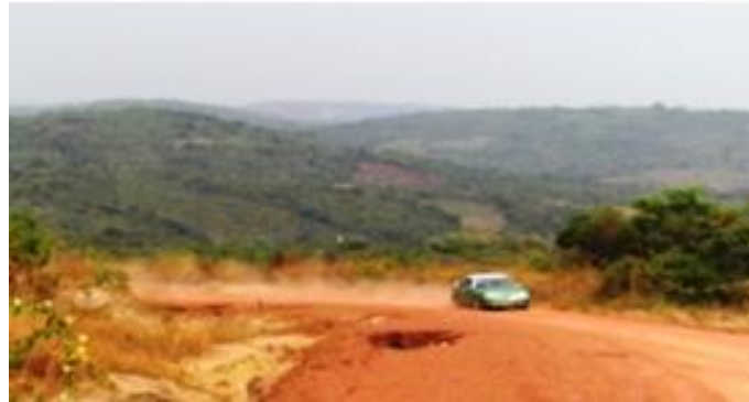
Photo 27: Perte des matériaux (levée de poussière) sur la piste de Mayitoukou © Idriss M'bouka Milandou, 2015
