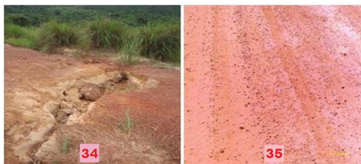
Photo 34 : Traverse, Photo 35 : Tête de chat Piste latéritique de Mayitoukou- Goma tsé-tsé © Idriss M'bouka Milandou, 2015
