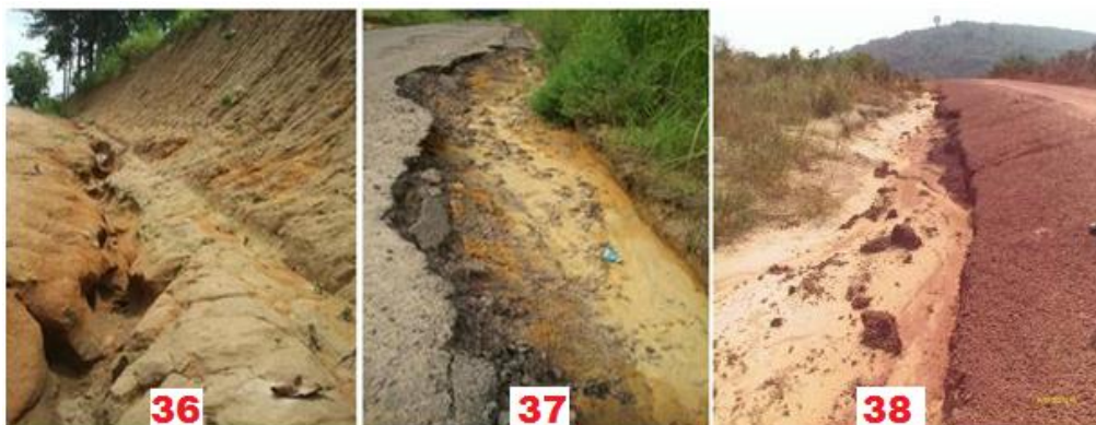
Photo 23 : Erosion de déblai de piste vers Linzolo (2015), Photo 37 : érosion de fossé vers Samba-Alphonse (2014), Photo 38 : érosion de fossé sur la piste de Mayitoukou (2015)
