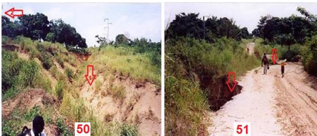
Photo 50 : Grand ravin de Mabenga entre 2005 et 2010 (la flèche 1 indique l'ancien tracé de la route, la flèche 2 montre le côté où se situait la déviation), Photo 51 : Rétrécissement de la piste vers Massissia par deux ravins régressifs.
