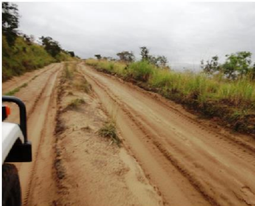
Photos 22 : Vue du tronçon Case Barnier -Loumou
