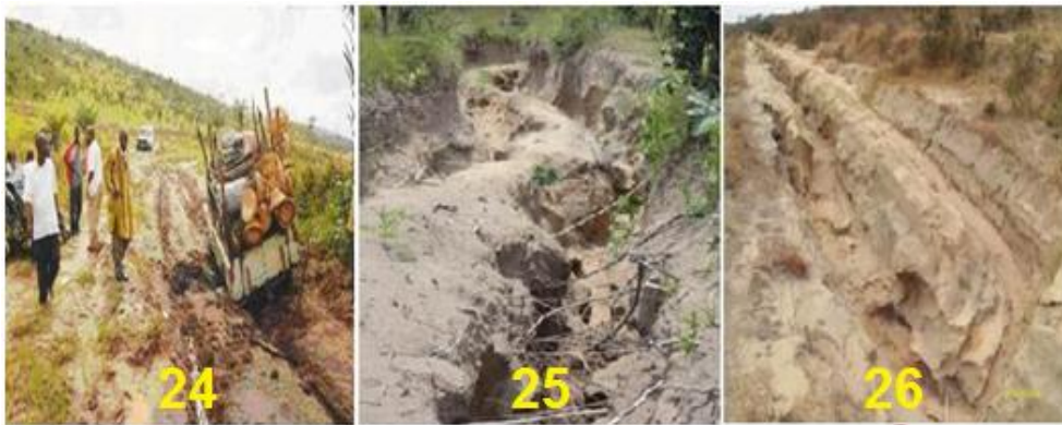
Photo 24 : Blocage d'un camion dans une ornière de gravité 2 vers Nguiri ; Photo 25 : Ornières de niveau 3 sur une piste abandonnée vers Kibossi ; Photo 26 : Ornières de niveau 3 vers Case Barnier. © Idriss M'bouka Milandou, 2014
