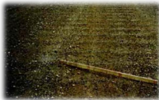
Photo 28 : Exemple des tôles ondulées sur une route au Mali. © Anonyme, 2006
