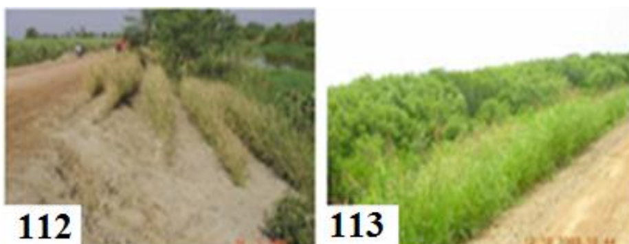
Photos 112 et 113: vétiver stabilisant les rebords d'une piste au Vietnam.
