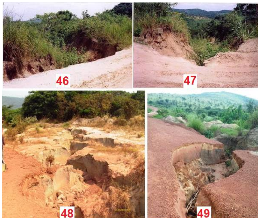
Photos 46 et 47 : Ravins régressifs sur la piste de Linzolo (2009), Photos 48 et 49: Ravines régressives sur la piste Mayitoukou- Goma tsé-tsé (2015). © Idriss M'bouka Milandou
