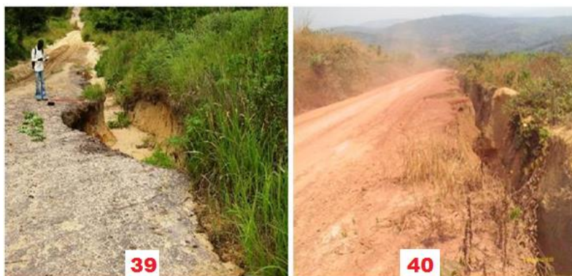
Photo 39 : Ravine longitudinale sur la route du Linzolo en 2008 ; Photo 40 : Ravine longitudinale sur la piste latéritée de Mayitoukou en 2015. © Idriss M'bouka Milandou
