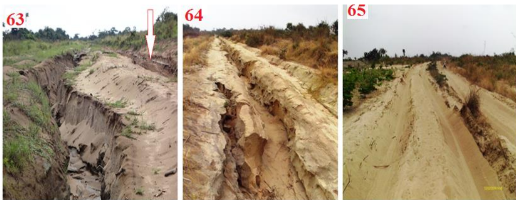
Photo 63 : Ravine sur l'ancienne piste (la flèche indique la nouvelle piste juste à côté de l'ancienne), Photo 64 : Ornières évoluant en ravines- section de piste totalement abandonnée, Photo 65 : Ensablement de la piste au niveau de case Barnier.
