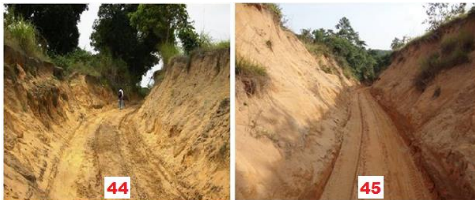
Photo 44 : Surcreusement sur la piste Linzolo à Mabenga entre 2006 – 2009,
