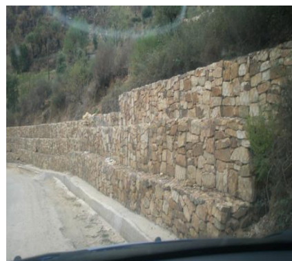
Photo 120 : Stabilisation d'un talus instable par le gabionnage. © www.google.com
