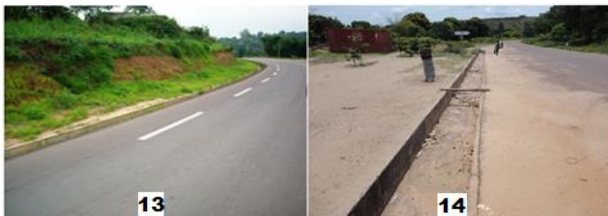
Photos 13 : Section de la route Brazzaville-Kinkala, à l'entrée de la commune de Kinkala (2012) ; Photo 14 : Section de la de la route Brazzaville-Kinkala vers Koubola (2015).
