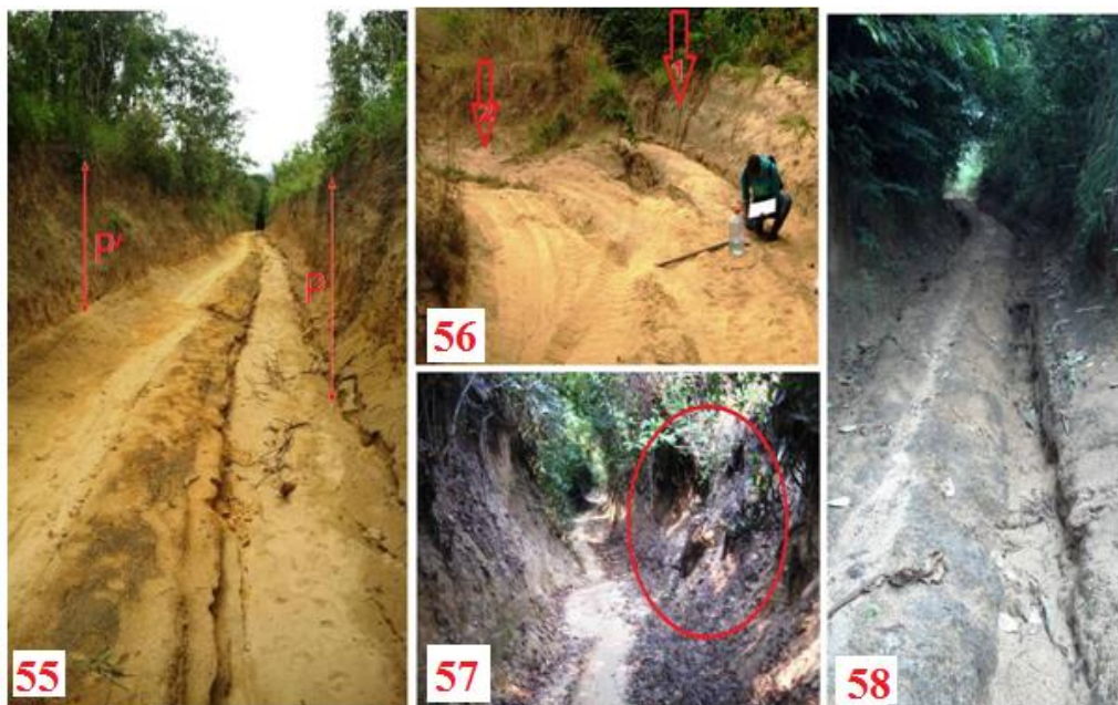
Photo 55 : Surcreusement rectangulaire sur plus 200 m de long et de près de 2 m de profondeur, Photo 56 : Ornière grave sur la piste de Mayala (la flèche 1 indique la piste surcreusée abandonnée et la flèche 2 montre la nouvelle piste de déviation), Photo 57 : Bretelle de la piste moyennement surcreusée et jonchée d’ornières à l’abandon, Photo 58 : Effet de chablis sur une vieille section de piste surcreusée. Piste Koubola-Bissinza.
