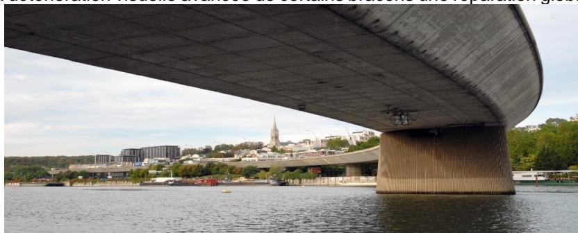
Figure IV-29 : Le viaduc de Saint-Cloud (Crédit photo - H. Delahousse, Ifsttar).
