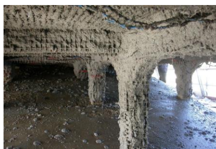
Une pulpe de papier imbibée d'un électrolyte alcalin a été projetée à la surface du béton, enrobant l'anode en acier fixée temporairement à la surface du béton
