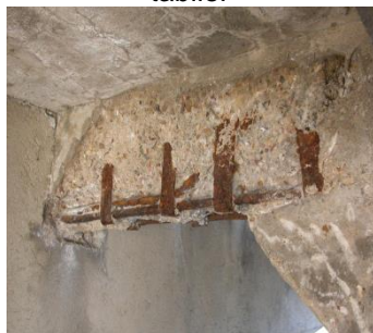
Etriers plats et armatures
