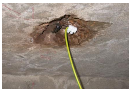
Les connections entre armatures ont été vérifiées et en environ tous les 1m 2 , les armatures ont été connectées à un générateur de courant électrique.
