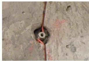
Anode forée (DurAnode CPI) (Réseau anodique)
