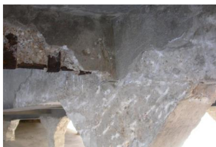
Les enduits et bétons non adhérents ont été purgés
