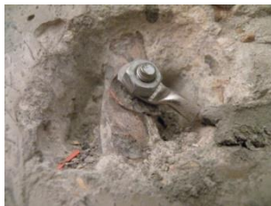
Connexion aux armatures (Réseau cathodique)
