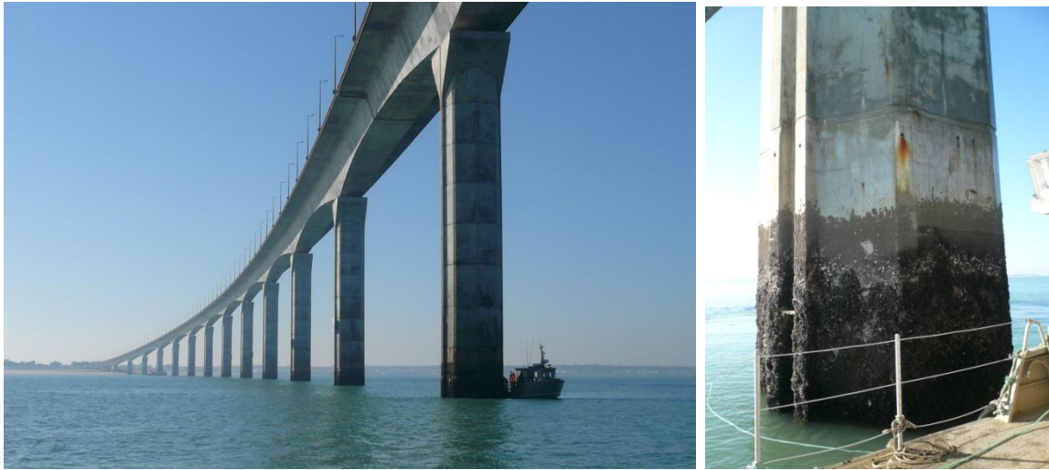
Figure V-2 : Pont de l'île de Ré (crédit photo : S. Pasquet, Cerema)
