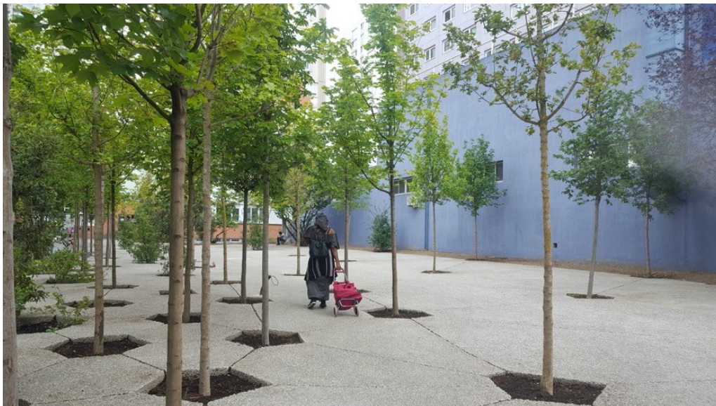
Figure 21 : Finalisation du revêtement urbain poreux sous forme de dalles non jointives. Source : photo prise par l'auteure le 10/07/2020
