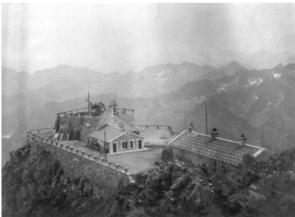
Figure 2.7 – Le site probablement autour de 1886. À gauche, le blockhaus; à droite, le bâtiment Nansouty | © Régie du Pic du Midi
