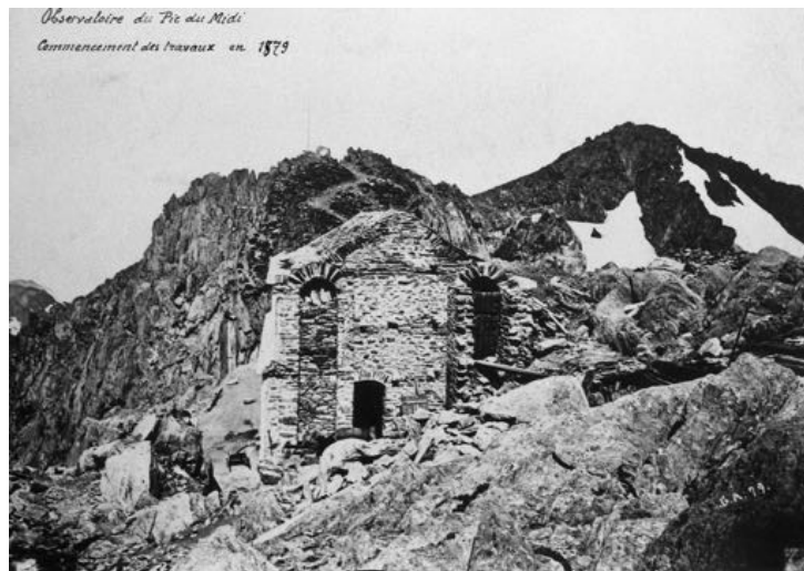
Figure 2.6 – Les travaux de construction du bâtiment Nansouty en 1879 | © Régie du Pic du Midi
