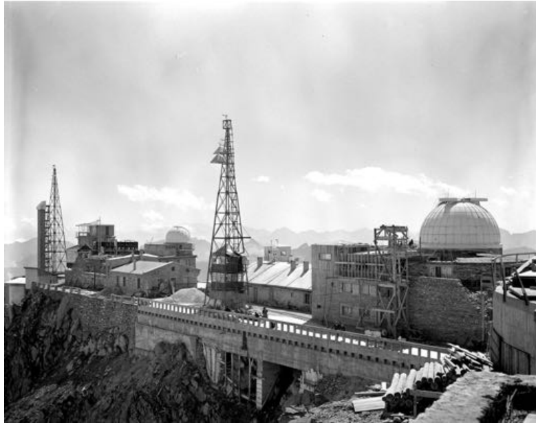
Figure 2.12 – L'Observatoire durant les travaux du bâtiment interministériel, 9 septembre 1962 | © Régie du Pic du Midi
