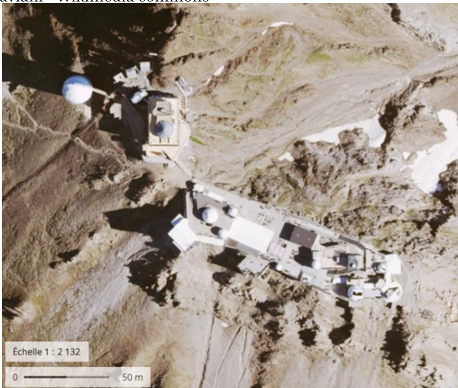
Figure 2.5 – Vue satellite de l'Observatoire du Pic du Midi. | © 2016 - Géoportail
