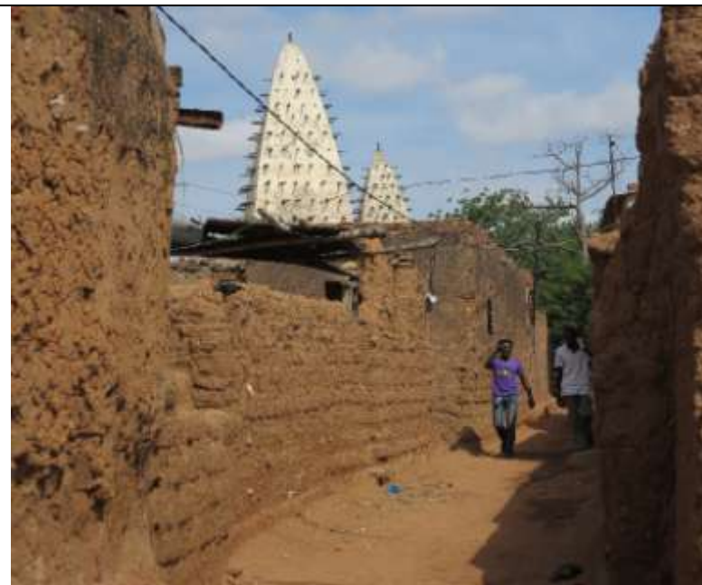
Illustration 7. Une ruelle de Kibidoué où le banco apparaît comme le principal matériau de construction
