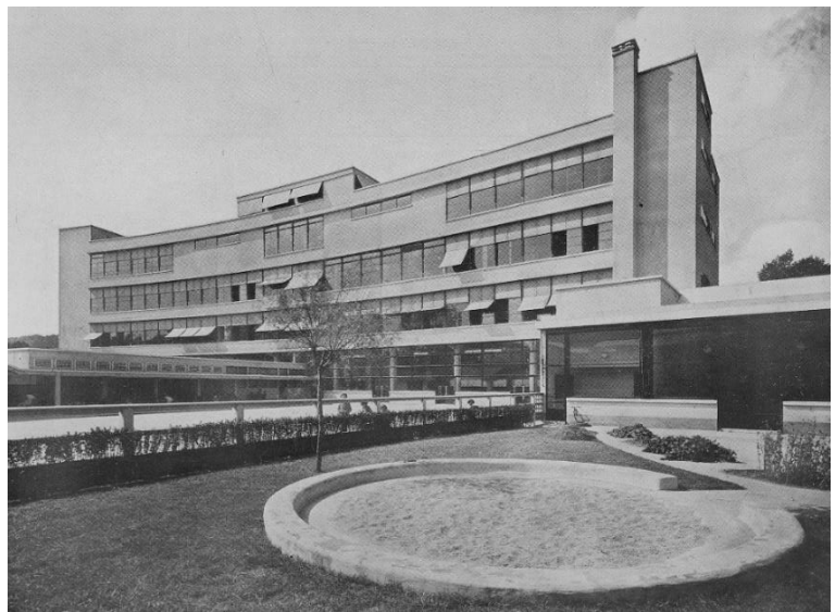
Figure 189 : Groupe scolaire Jean-Baptiste-Clément, Boulogne-Billancourt (92), Jacques Debat-Ponsan architecte, 1933. In La Construction Moderne , 20 janvier 1935, 50 ème année, n°16, p. 359.
