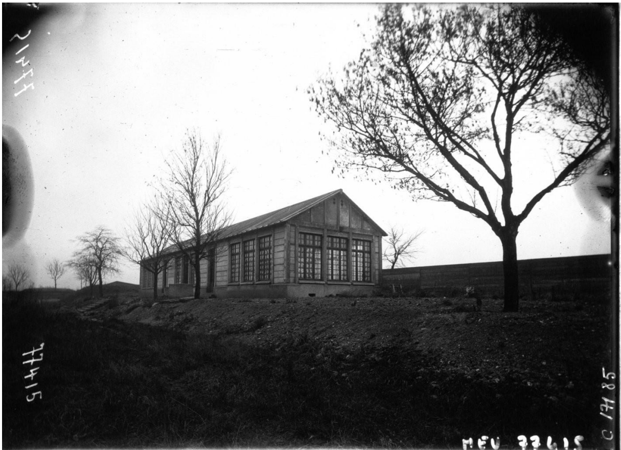
Figure 148 : Pavillon de l'école de plein air du boulevard Bessières, 1919. Paris : Agence de presse Meurisse. Notice disponible sur : http://gallica.bnf.fr/ark:/12148/btv1b9033280s/f1.item
