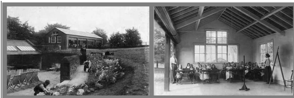
Figure 139 : Whiteley Wood open-air school, Sheffield (Angleterre), photos de 1913. À gauche, une vue extérieure d'un des pavillons d'enseignement en cas d'intempéries ou pour les activités didactiques qui nécessitent un mobilier spécifique. À droite, le pavillon des jeunes filles vu de l'intérieur. AM de Sheffield MD7503/1/1. Disponible en ligne : http://picturesheffield.com/frontend.php?action=printdetails&keywords=Ref_No_increment;EQUALS;arc01315&prevUrl= , consulté le 15 février 2016.
