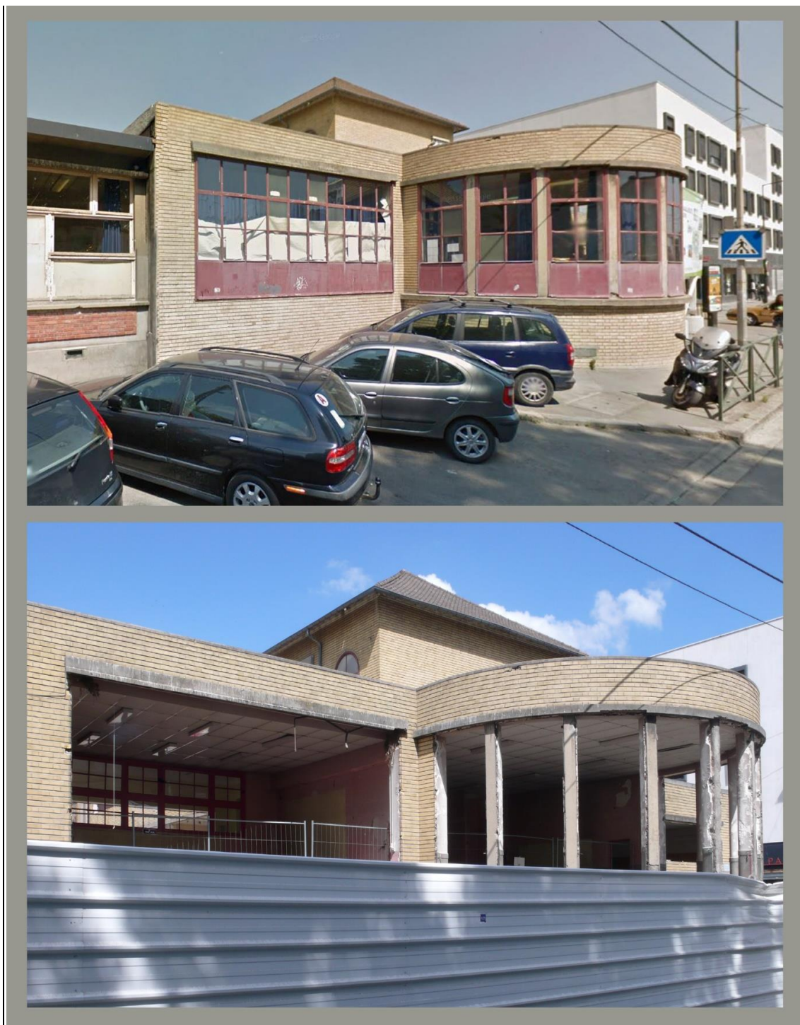
Figure 238 : Groupe scolaire Eugène Varlin, Pierrefitte-sur-Seine (93), La Guilde des architectes et techniciens conseils, 1935. En haut, état été 2015, photographie personnelle prise le 13 juillet 2015. En bas, état printemps 2016, photographie personnelle prise le 24 mai 2016.
