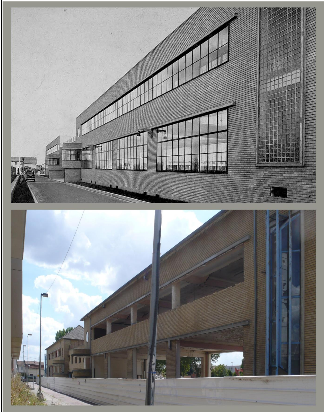
Figure 236 : Groupe scolaire Eugène Varlin, Pierrefitte-sur-Seine (93), La Guilde des architectes et techniciens conseils, 1935. En haut, vue de l'entrée, in L'Architecture Aujourd'hui , mai 1936, 7 ème année, n°4, p. 34. En bas, état printemps 2016, photographie personnelle prise le 24 mai 2016.
