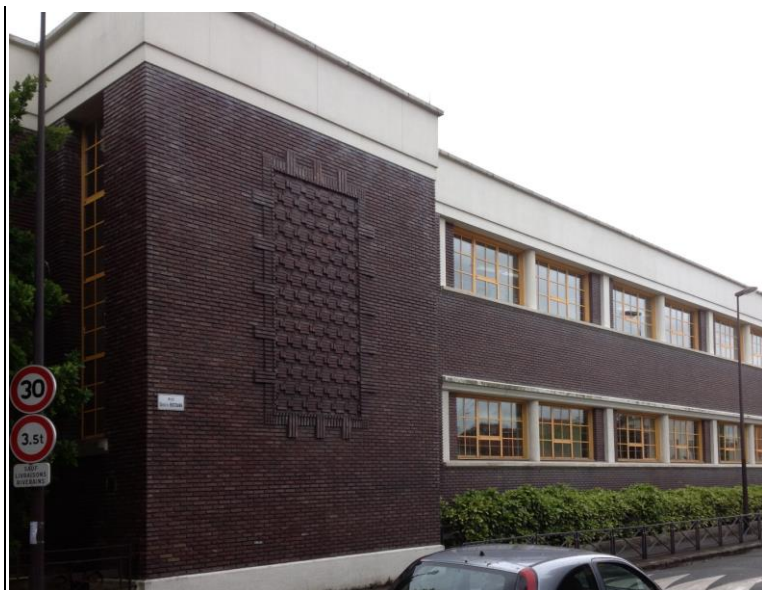
Figure 215 : Groupe scolaire Jules Michelet, Vitry-sur-Seine (94), les frères Chevallier architectes, 1939. Vue du parement de brique ornant la cage d'escalier de l'ancienne école primaire élémentaire de filles. Photographie personnelle, prise le 13 mars 2013.
