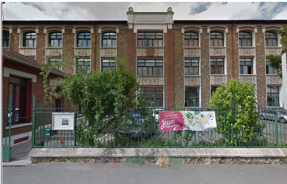
Figure 95 : Groupe scolaire Pasteur, Villejuif, juin 2015. © 2016 Google.
