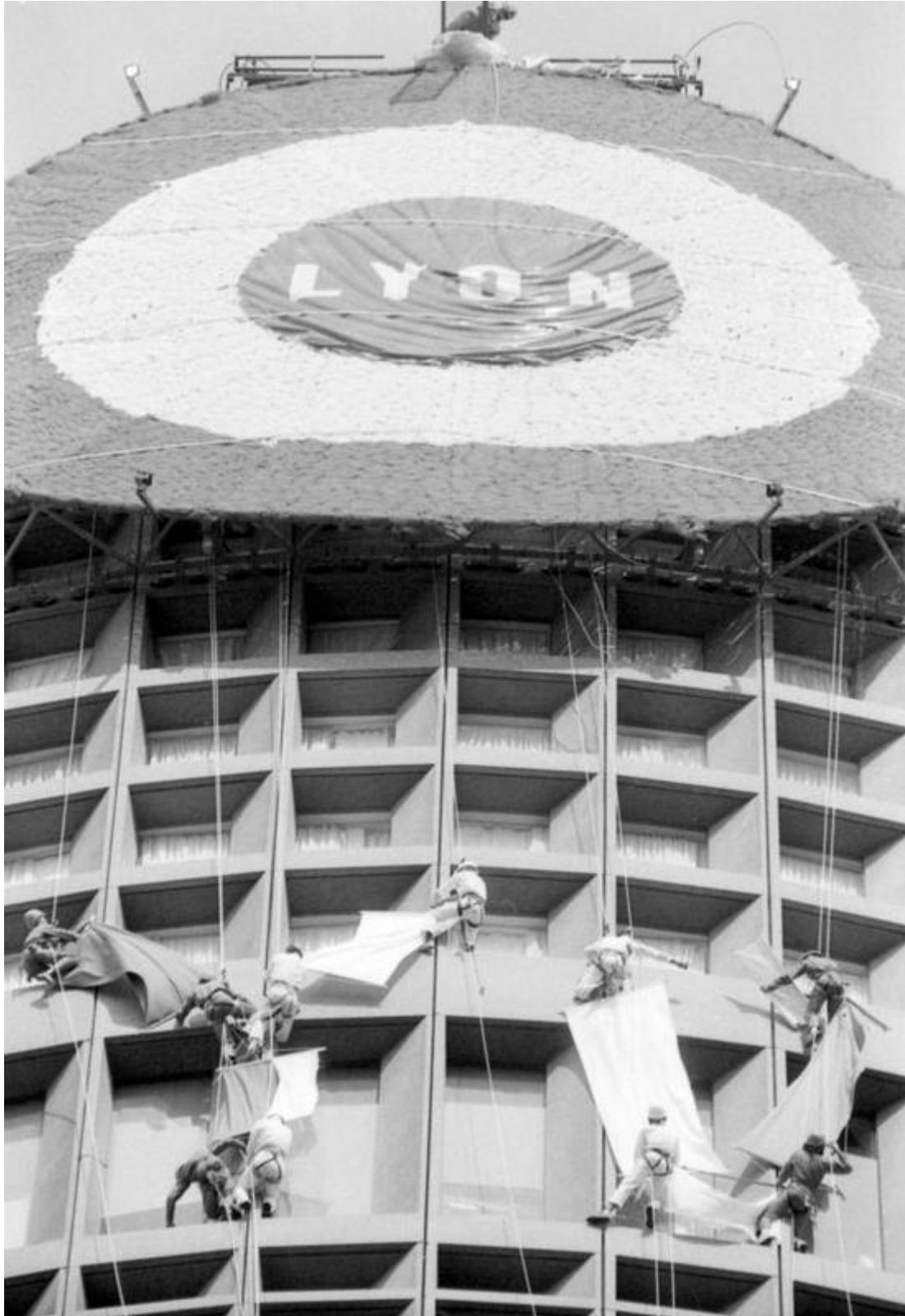
Document V-3 – Démontage de la cocarde du Bicentenaire réalisée par EMC sur la Tour Part-Dieu, août 1989
