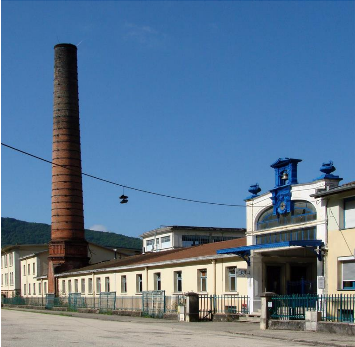
Document II-5– Les vestiges de l’usine de la Schappe de Saint-Rambert en 2014
