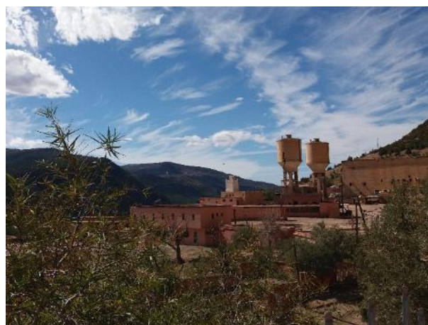
Photo 6.7 : Les deux bétonnières utilisées pour le transfert des bétons au barrage sont encore un témoin de l'ère de la construction du barrage Bin El Ouidane (Cliché : R. BISSOUR, 2018)
