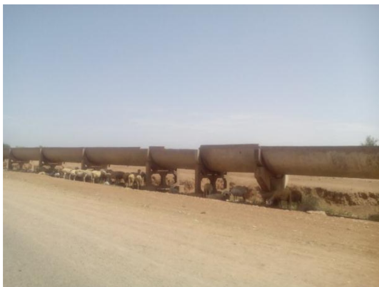
Photo 7.11: Canal tertiaire de l'irrigation du périmètre de Béni Moussa.
