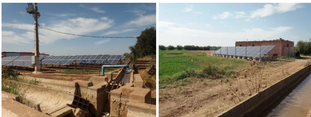
Photo 9.1 et 9.2: L'utilisation des panneaux solaires dans le périmètre de Béni Moussa pour le pompage des eaux souterraines et les déverser dans les canaux d'irrigation.
