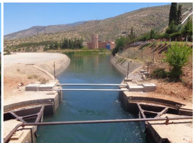
Photo 7.4 : Déviateur des eaux d'irrigation vers le canal G et T. Cliché : R. BISSOUR, 2014
