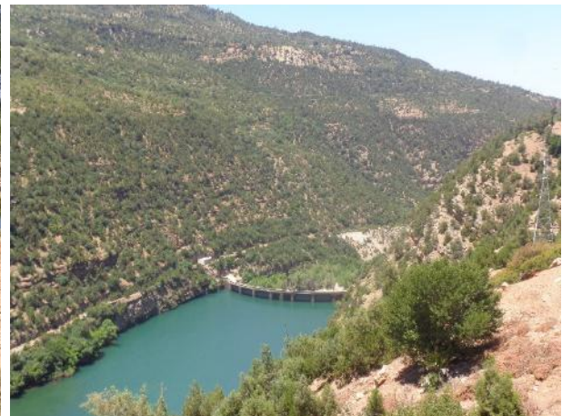
Photo 7.2 : le barrage de compensation d'Ait Ouaârda. Cliché : R. BISSOUR, 2014
