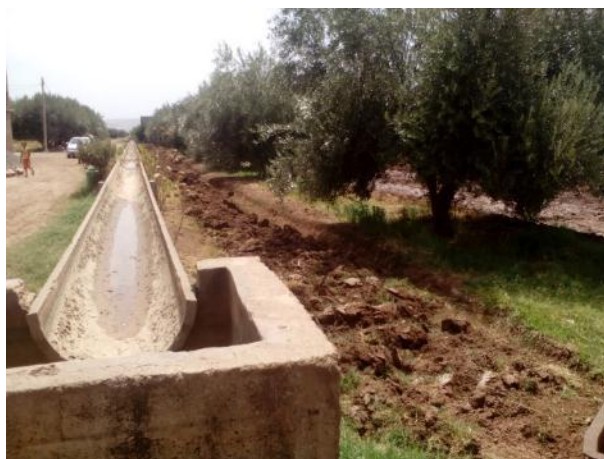
Photo 7.10: canal à ciel ouvert des eaux d'irrigation Cliché : R. BISSOUR, 2016
