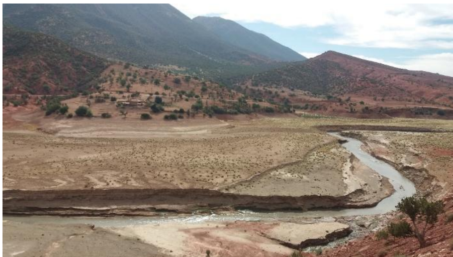
Photo 6.15 : Volume des sédiments apportés et déposés au fond de la retenue de Bin El Ouidane.
