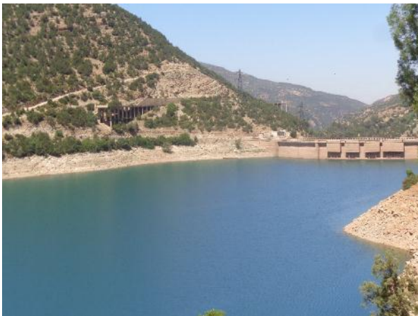
Photo 7.1 : la retenue du barrage de Bin El Ouidane. Cliché : R. BISSOUR, 2014
