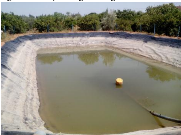
Photo 9.5 : un bassin réservoir utilisé en système d'irrigation goutte-à-goutte. Cliché R. BISSOUR (2016)
