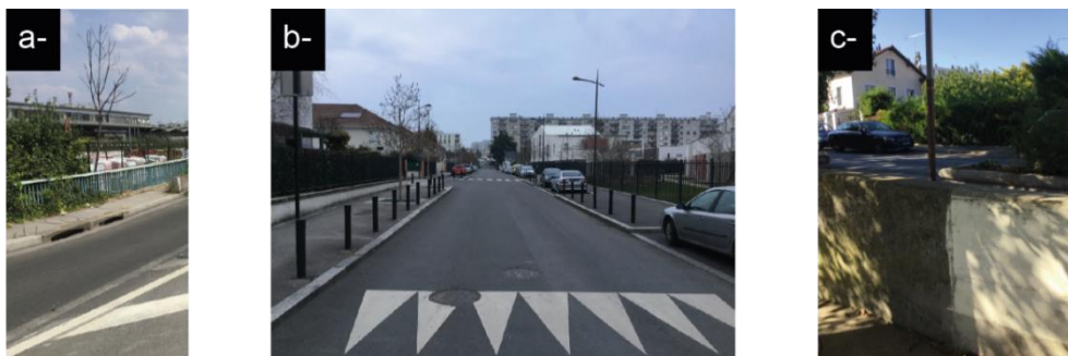
Légende : a) Entrée d'égout, b) Regard d'égout, c) Mur de soutènement
