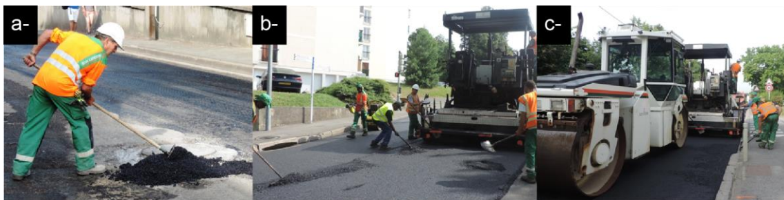
Figure 10-10 – Application d'un revêtement bitumineux
