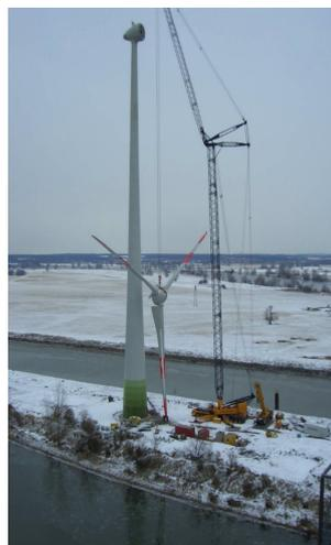
(b) Éolienne à axe horizontal modèle E-70 ayant un rotor de 71m de diamètre et une puissance de 2.3MW
