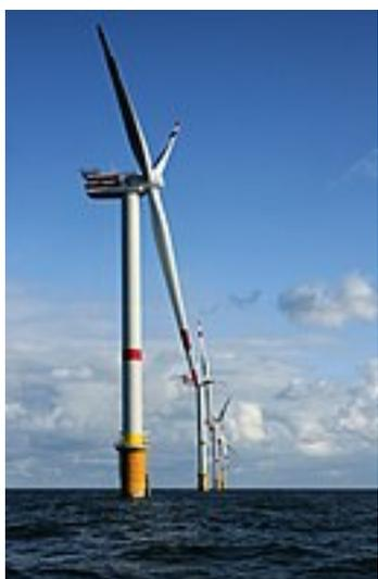
(a) Éoliennes off-shore, le modèle RePower 5M a un rotor de 126m de diamètre pour une puissance de 5MW
