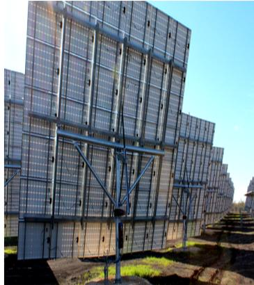
FIGURE 2.10 – Centrale de panneaux tracké sur deux axes
