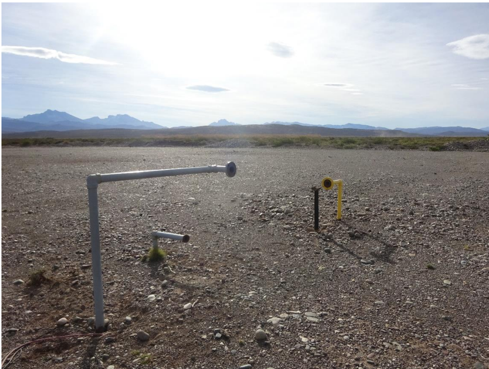
Anciennes conduites sur une plateforme désaffectée ©Tobias Etienne-Greenwood
