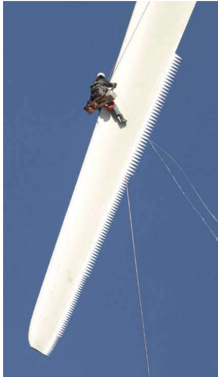
FIGURE 1.7 – Dispositifs dentelés de réduction de bruit («serrations»), issu de Bowdler et Leventhall, 2012 .
