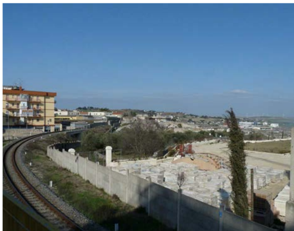
La rupture ferroviaire
