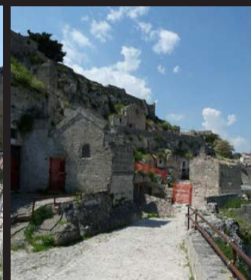
Chantier dans le Sasso Caveoso
