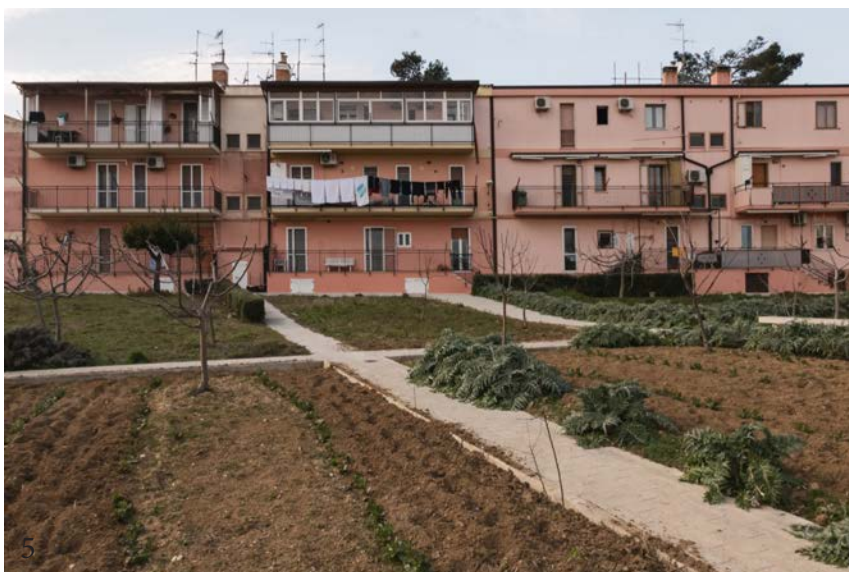
Fig 15. Sites identifiés par l'ODS sur le quartier Serra Venerdi Source : https://venuesofmatera.matera-basilicata2019.it (consulté le 29.05.2020)
