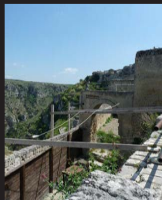
Chantier dans le Sasso Caveoso
