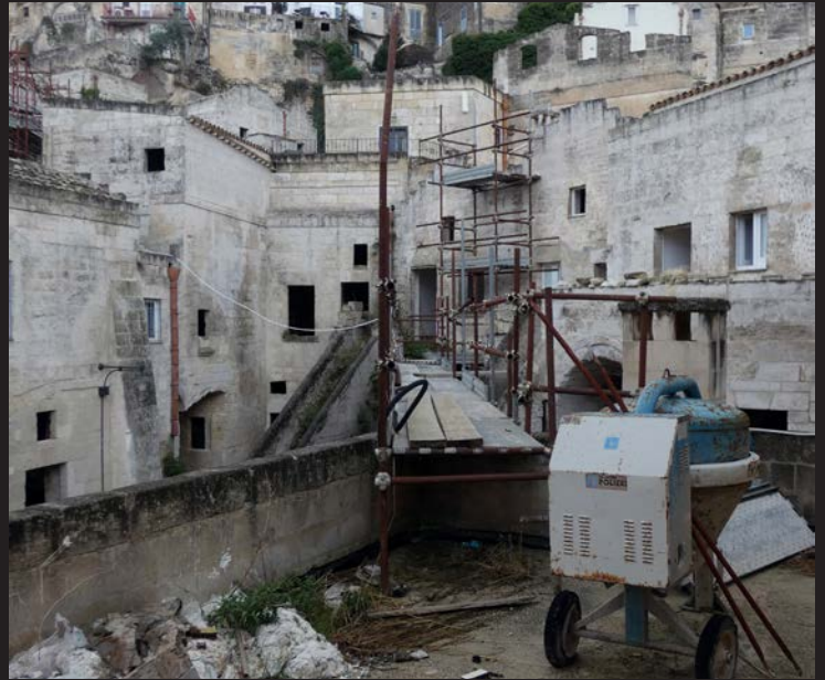
2. Le vicinato photographié par Cartier-Bresson en chantier
