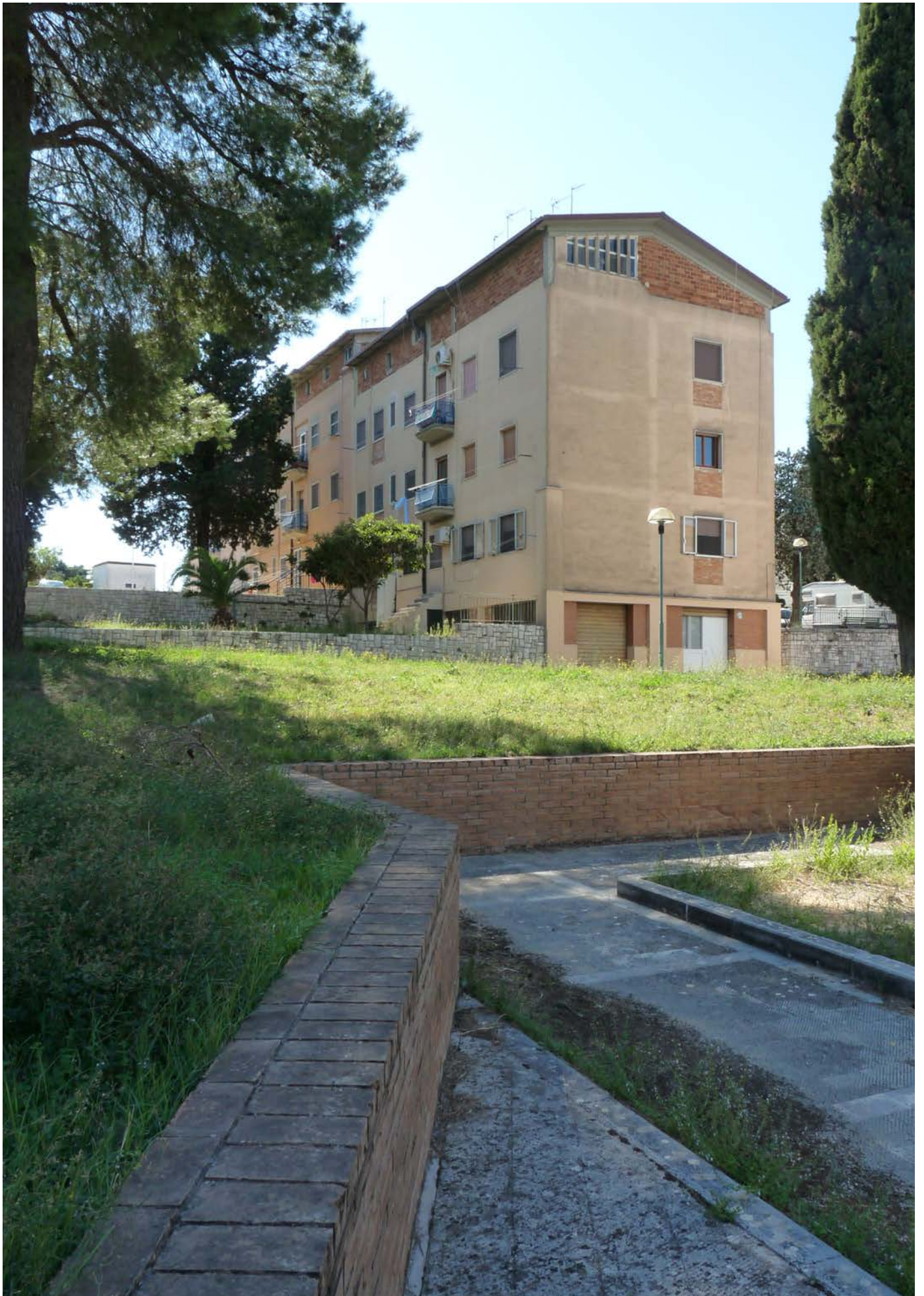
Fig 1. Le quartier de Lanera Source : photographie de M.Rotolo (septembre 2017)
