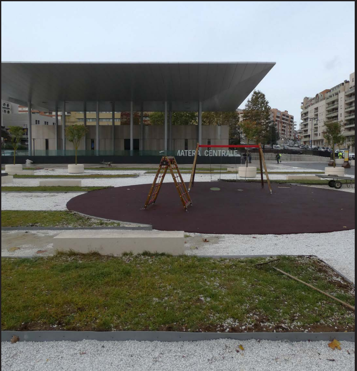
Fig 54. La nouvelle gare des Ferrovie Appulo Lucane Source : photographie de M.Rotolo (novembre 2019)
