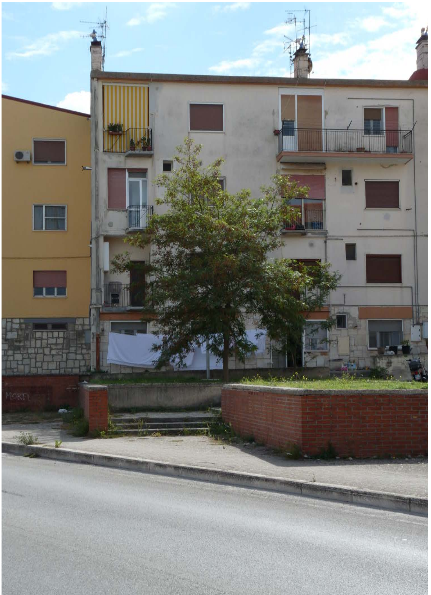
A3. Le quartier de Piccianello Sources : photographies de M.Rotolo (octobre 2017)
