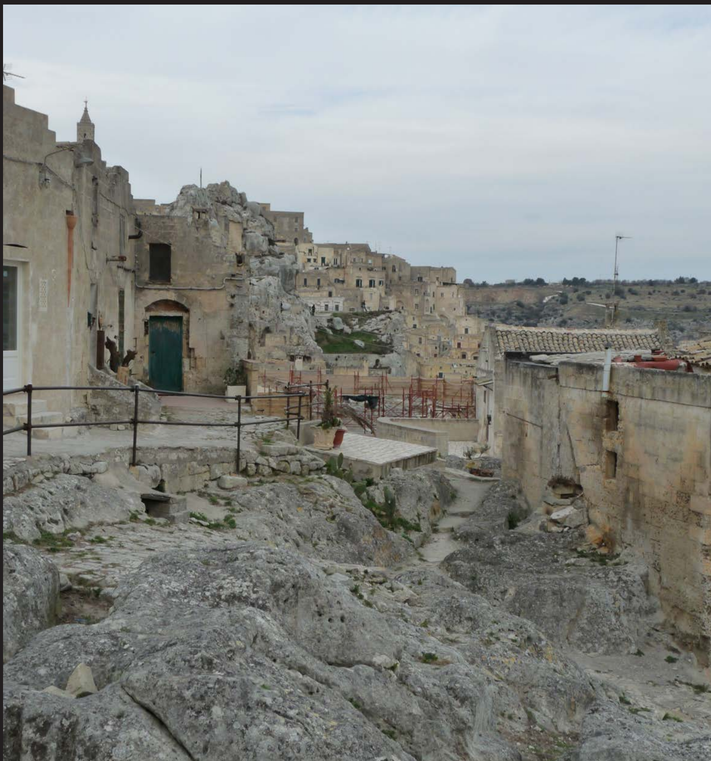
Fig 12. Vue sur la Madonna dell'Idris depuis le Sasso Caveoso Source : photographie de M.Rotolo (février 2018)
