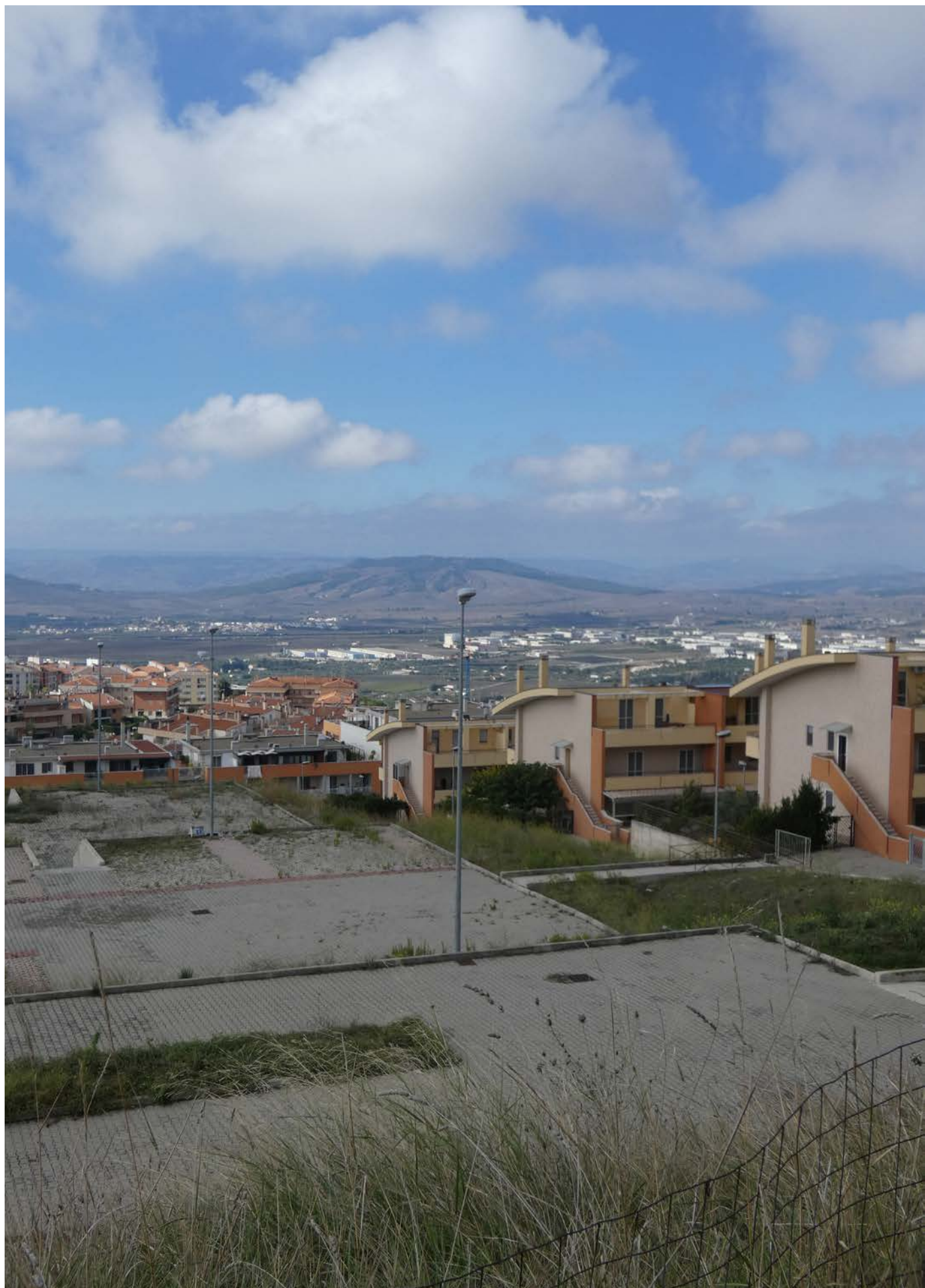
A6. Le quartier de Serra Rifusa Source : photographie de M.Rotolo (septembre 2017)
