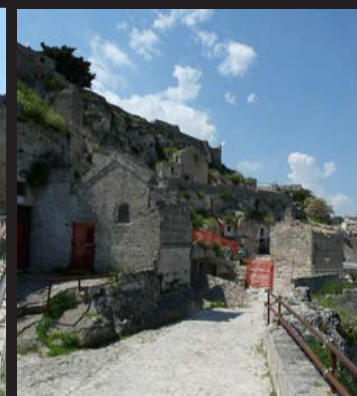
Chantier dans le Sasso Caveoso
