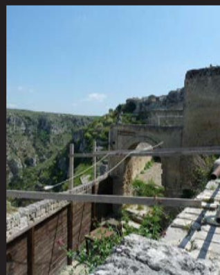
Chantier dans le Sasso Caveoso
