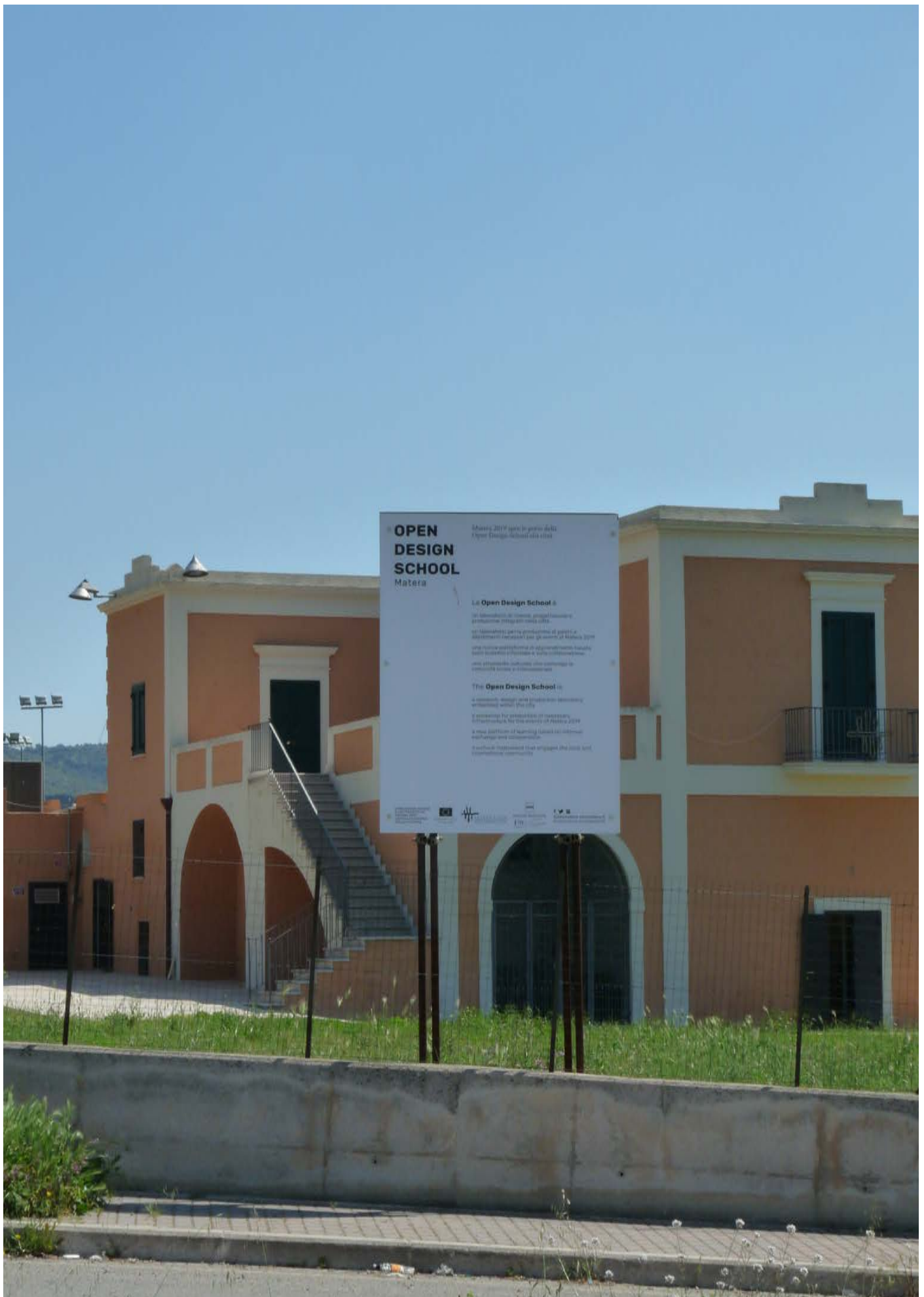
Fig 9. Le Casino Padula, siège de l'Open Design School Source : photographie de M.Rotolo (avril 2018)
