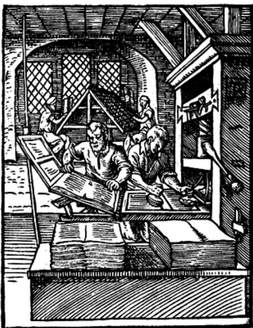
FIGURE 1.13. – Presse à imprimer vers 1568 ; 240 impressions par heure.
