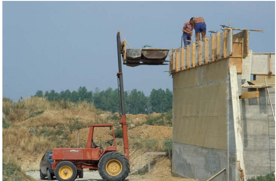
Fig. 8 : Coffrage en bois à progression linéaire, de longueur augmentée ; chantier des architectes Odile Perreau-Hamburger et Jean-Michel Savignat, Domaine de la Terre de Villefontaine, Isère, été 1984 (H. Guillaud).
