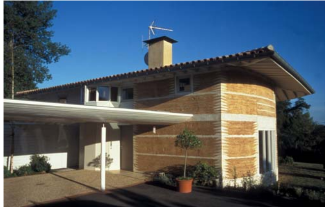
Fig. 17 : Villa en pisé à mur courbe mis en œuvre avec un coffrage intégral en structure acier et panneaux de bois tripli. Maison de Philippe Rabier, à Anglet, Pyrénées-Atlantiques (S. Dugelay, 2003).
