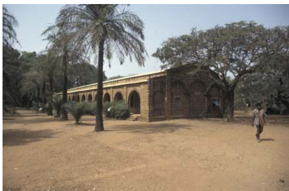
Fig. 10 : Séminaire construit en blocs de latérite découpés, Burkina Faso. © Vincent Rigassi, CRATerre-EAG
