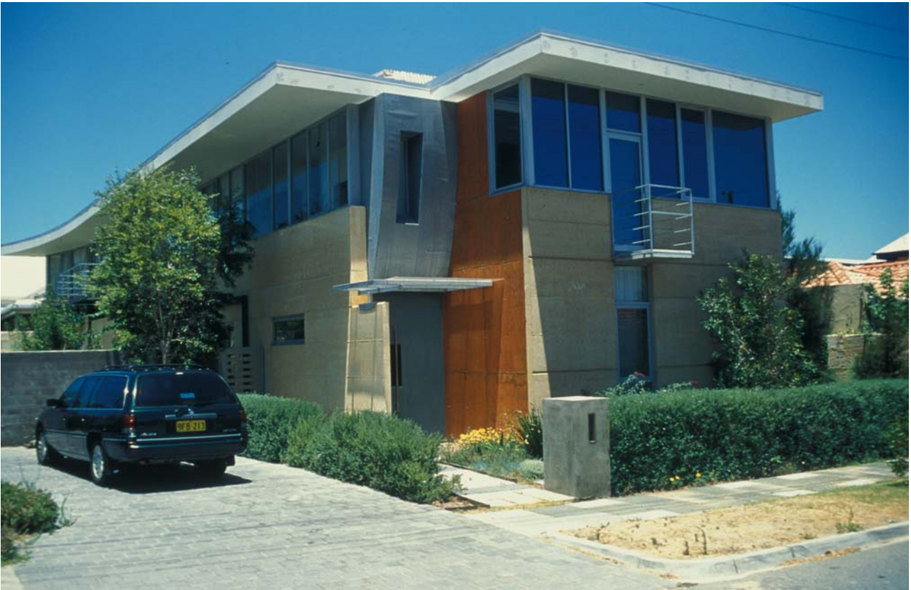
Fig. 36 : Villa en pisé dans la périphérie de Perth, Western Australia , réalisée par l'entrepreneur Stephen Dobson, société Ramtec (Ph. Garnier, fin des années 1990).
