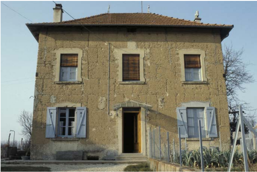
Fig. 4 : Corps d'habitation d'une ferme en pisé et béton (cuvelage de cave, soubassements et allèges du rez-de-jardin, tableaux des baies de l'étage), datée de 1914, sise à Dolomieu, nord de l'Isère (H. Guillaud).
