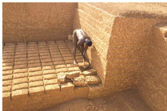
Fig. 9 : Extraction manuelle de blocs de sol latéritique au Burkina Faso. © Vincent Rigassi, CRATerre-EAG
