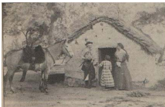
Fig. 14 : Rancho rural en « terrones », Uruguay, début du XX ème siècle. © Archives de la Bibliothèque Nationale d'Uruguay à Montevideo. Document reçu de Cecilia Alderton, architecte.
