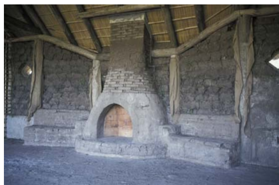
Fig. 19 : Intérieur : futur salon coin cheminée avant réalisation des enduits intérieurs. © Hubert Guillaud, CRATerre-EAG
