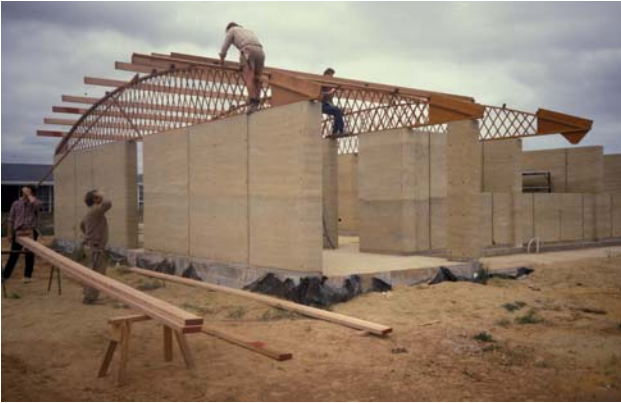
Fig. 21 : Construction de voiles de pisé auto stables, mis en œuvre en coffrage intégral d'aluminium, chantier de villa réalisé à Wanabee, banlieue de Melbourne, par l'entreprise Terraco Ltd (H. Guillaud, 1988).
