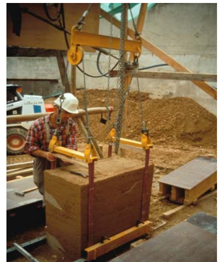
Fig. 19 : Réalisation d'un bloc de pisé préfabriqué et système de levage par palonnier et grue, chantier d'un logement en pisé à Montbrison, Loire, début des années 1990).
