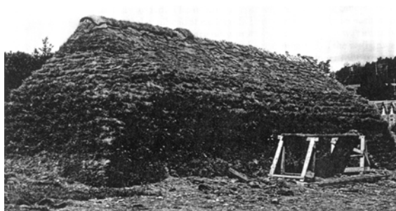
Fig. 13 : Bâtiment expérimental construit en « turf », Musée de Kingussie, Highlands, Ecosse, 1982-83. Etape finale : couverture en « divots ». © Ross Noble et Musée de Kingussie.
