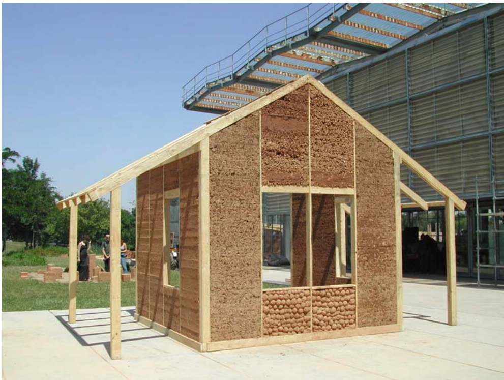
Fig. 41 : Prototype d'habitat léger en bois et panneaux en béton de terre et granulats coulés, réalisé par l'architecte Christophe Wilke aux Grands Ateliers de Villefontaine à l'occasion de la manifestation Grains d'Isère 2005 (H. Guillaud).
