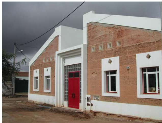
Fig. 33 : Marché couvert réalisé en pisé dans une petite ville du sud du Portugal, années 1990 (H. Guillaud, 2005).
