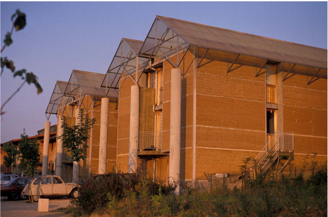
Fig. 23 : Projet de Gilles Perraudin et Françoise Jourda, Domaine de la Terre de Villefontaine, Isère, 1993-85. Murs en « T » et en « L » mis en œuvre en coffrage intégral métallique (H. Guillaud).
