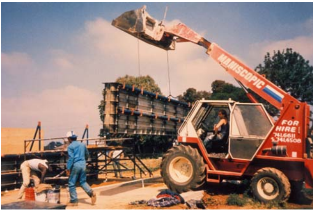
Fig. 15 : Coffrage intégral en aluminium, utilisé sur un chantier de la région de Melbourne, Australie (Entreprise Terraco Ltd, Wanabee, milieu des années 1980).
