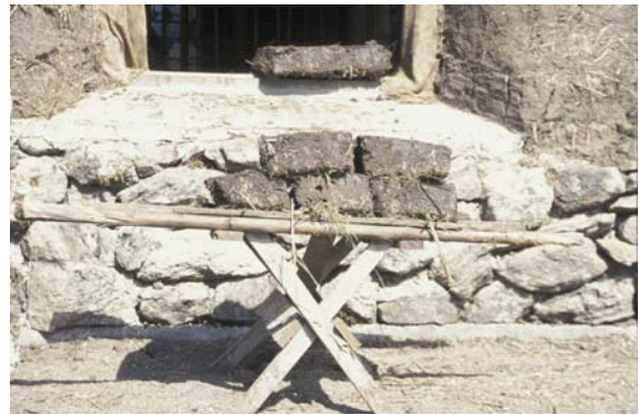
Fig. 17 : chaise en bois servant au transport des mottes de gazon fraîchement coupées jusqu'au pied du mur. site de Tierra Alta (maison Alderton-Urrestarazu) en novembre 2000. © Hubert Guillaud, CRATerre-EAG
