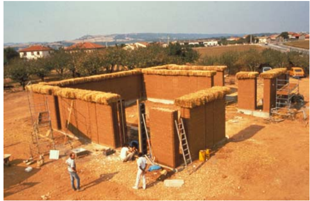
Fig. 22 : Chantier de la Halle de vente du Panier Fermier, association d'agriculteurs, Creux-De-la-Thine, Drôme, réalisé par les étudiants du CEAA-Terre de l'Ecole d'Architecture de Grenoble et les agriculteurs. Coffrage grim pant métallique pour panneaux de murs trumeaux (Th. Joffroy, années 1990).
