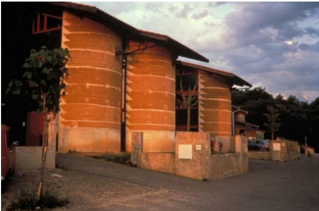
Fig. 16 b : Vue extérieure des cages d'escalier de forme courbe, projet de Jean-Vincent Berlotier, Domaine de la Terre de Villefontaine, Isère, 1983-85 (H. Guillaud).
