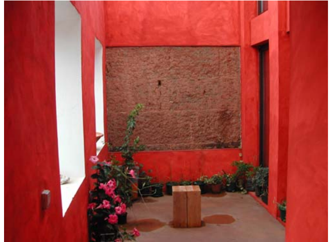
Fig. 30 : Vue intérieur sur patio, avec pan de mur en pisé brut, villa en pisé réalisée par l'architecte portugaise Teresa Berão en région d'Alentejo, fin des années 1990 (H. Guillaud, 2005).
