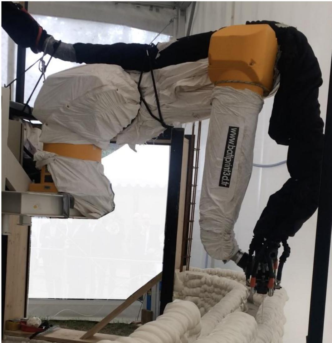
Figure 53. Procédé de fabrication additive Batiprint, Nantes, septembre 2017
