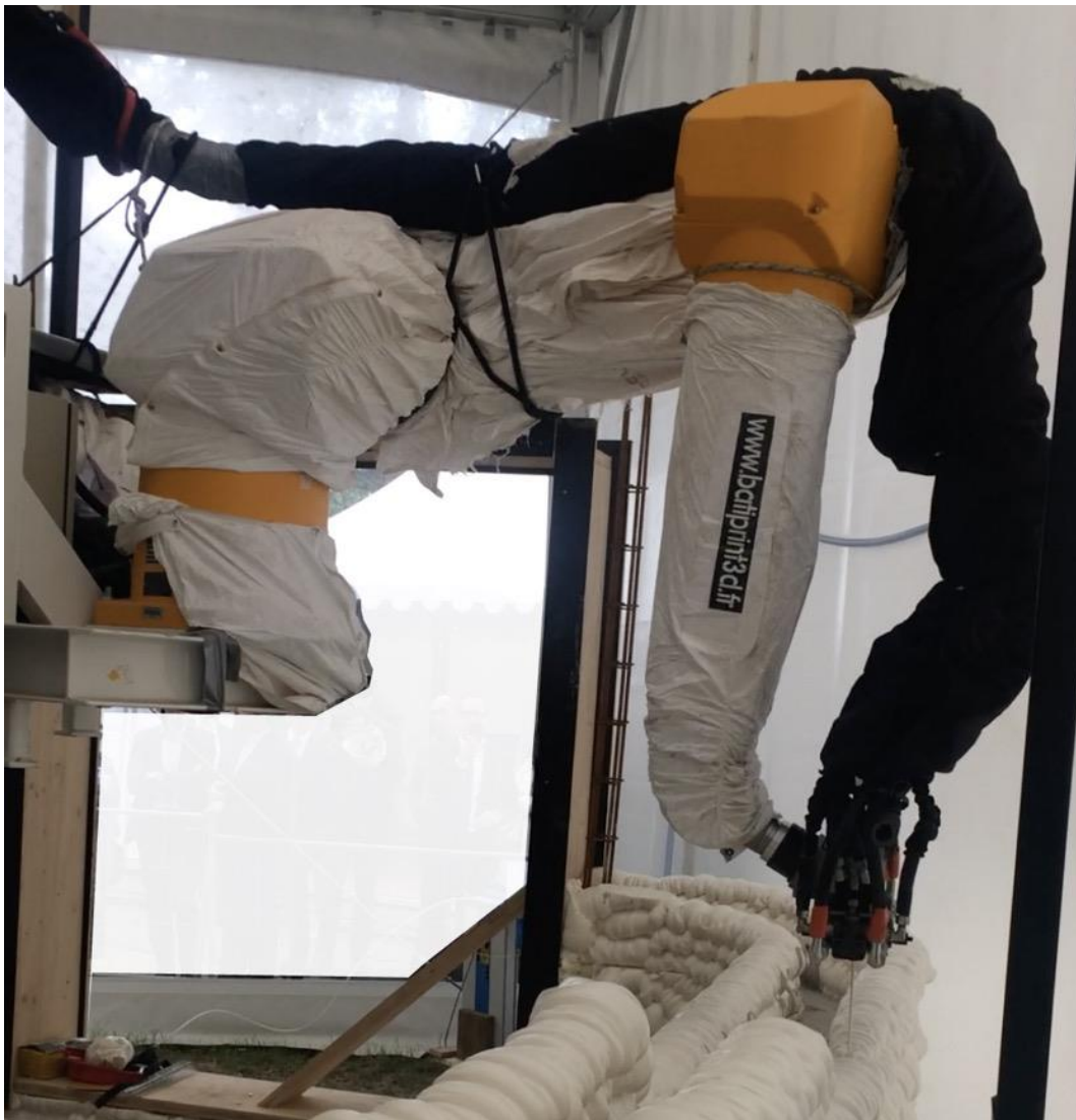
Figure 53. Procédé de fabrication additive Batiprint, Nantes, septembre 2017
