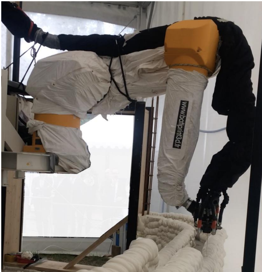
Figure 53. Procédé de fabrication additive Batiprint, Nantes, septembre 2017
