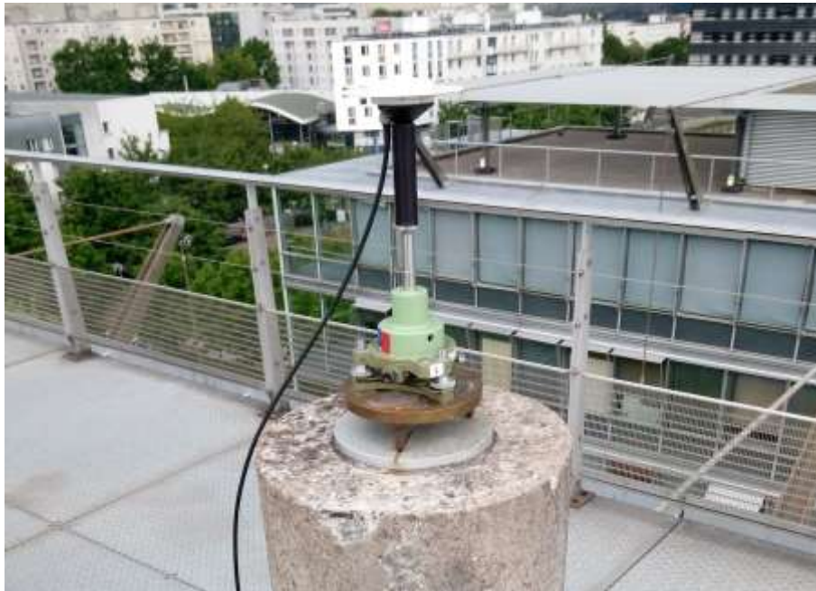
Figure II-17 Installation de l'antenne G3Ant sur un pilier du site d'essai
