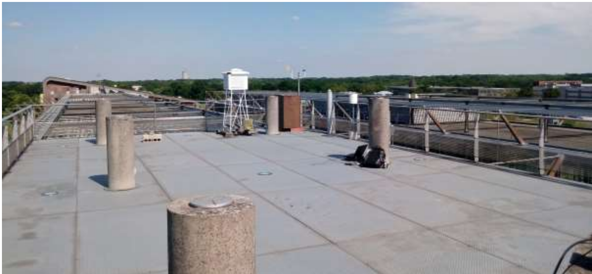
Figure II-16 Site d'essai avec les piliers référencés
