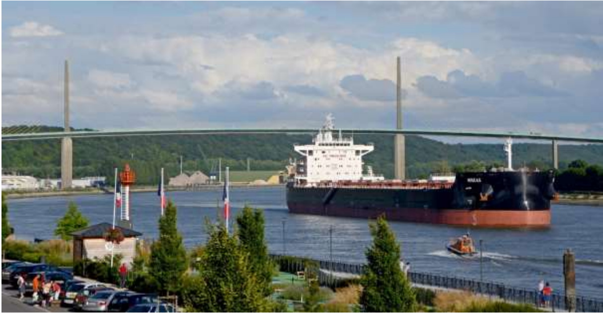
Figure III-2 pont de Brotonne (source : Wikimedia, par Pline – Travail personnel, CC BY-SA 3.0)
