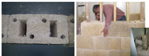
Figure 58: Montage de la paroi-test par notre partenaire industriel - EASY CHANVRE
