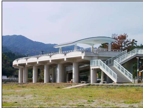
Figure 44 : Site refuge vertical au Japon (ville de Shirahama, préfecture de Wakayama) (crédit photo : N. Shuto, date inconnue)
