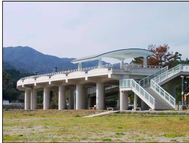
Figure 44 : Site refuge vertical au Japon (ville de Shirahama, préfecture de Wakayama) (crédit photo : N. Shuto, date inconnue)
