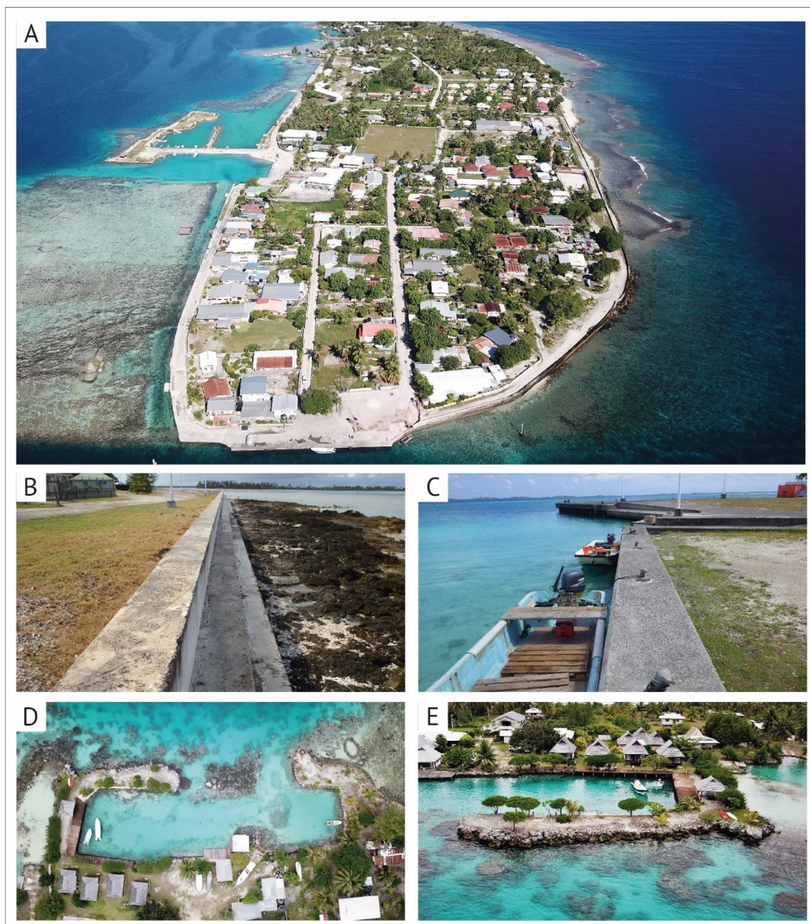
Figure 71 – Conséquences du remblaiement sur la nature du trait de côte des îles coralliennes d'atolls. (A) vue d'ensemble de l'île de Paeua depuis la passe Tairapa (Manihi). Cette photographie (mars 2018) montre le caractère fixé et artificiel du trait de côte de l'île-village de Manihi sur la quasi-totalité de son linéaire. (B) mur de protection érigé au-devant du remblai réalisé sur la côte océanique de l'île-village de Takaroa entre 1995 et 2013. On notera, en plus du caractère rigide du trait de côte, la différence topographique entre la partie remblayée sur le platier récifal (en herbe, à gauche du mur) et le conglomérat récifal océanique résiduel (de couleur sombre, à droite du mur), qui atteint environ 3 mètres. (C) Sur l'atoll de Ahe, un remblai a été réalisé sur la côte lagunaire, servant aujourd'hui de quai. (D) et (E) les remblais peuvent également être protégés par des enrochements, comme c'est le cas ici à la pension Manihi Pearl Village. Souvent, ces enrochements se retrouvent au-devant des remblais réalisés par les habitants et sont érigés avec les matériaux les plus grossiers issus du dragage du platier récifal. Photographies : V.Pillet.
