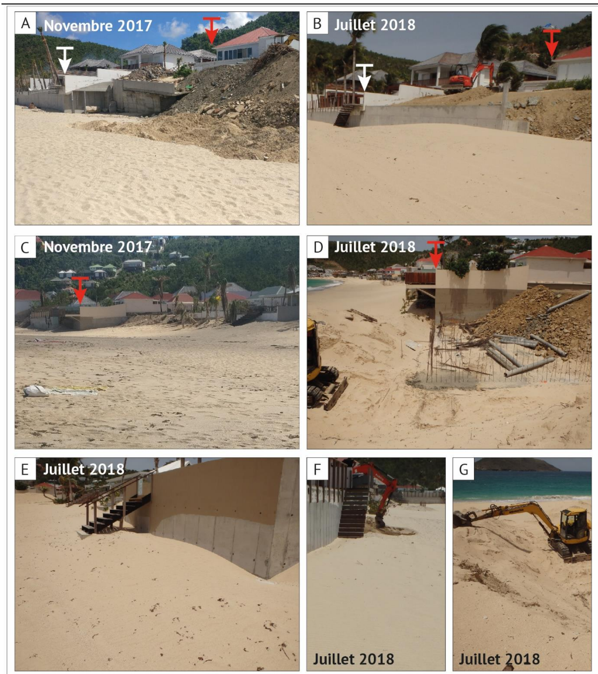
Figure 96 – Interventions anthropiques interférant avec les processus de réajustement planimétrique et vertical sur le site densément aménagé de Flamands. (A) et (B) localement, la consolidation des anciennes structures longitudinales côtières endommagées par les houles cycloniques et la construction de nouveaux ouvrages en haut de plage ont engendré une avancée artificielle de la position de la ligne de stabilité. (C), (D) et (E) pour se prémunir de l'assaut des houles de futurs cyclones certains habitants ont fait le choix de la protection lourde. Ici (A et B), les travaux étaient encore en cours en juillet 2018, mais contribueront à terme à rigidifier encore davantage un site déjà très artificialisé, comme le prouvent les ouvrages achevés (E). (F) extraction sédimentaire mécanique en haut de plage servant au remblaiement des zones situées en arrière des nouvelles structures longitudinales de haut de plage. (G) L'édification de nouvelles structures de protection implique un remaniement significatif des sédiments de la plage, ici au-devant du futur mur vertical de la photographie (B). Photographies : V.Pillet.
