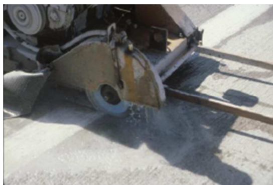
Figure I-3 1 - joint par sciage
