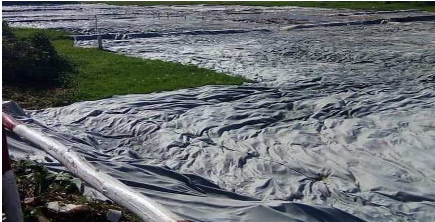
Figure II-3 10 – géotextile drainant / chantier « lalam-baovao » -Antananarivo
