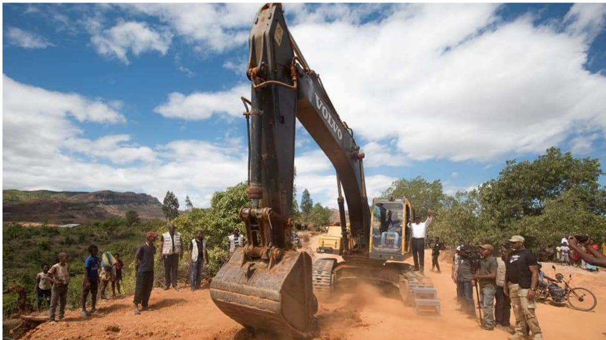
Figure II-2 29 - terrassement routier / Ambilobe-Vohemar
