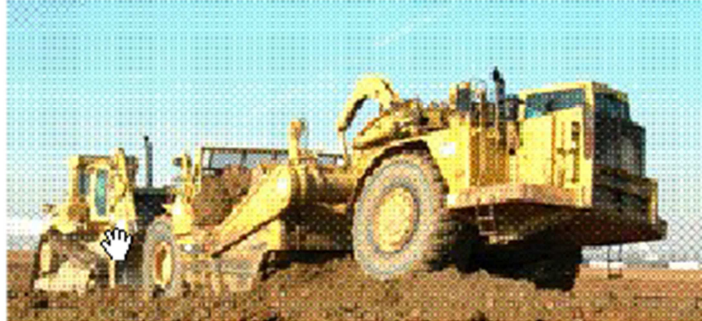
Figure I-2 5 - Décapeuse poussée par un buteur
