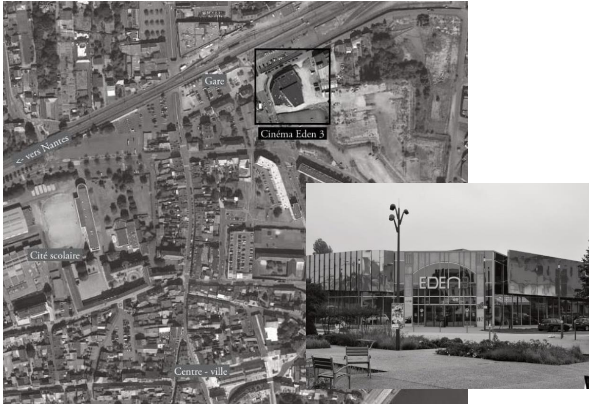
Figure 61 –Le Cinéma d'Ancenis, neuf, proche de la gare. Source : Ronan Keroullé, 2020
