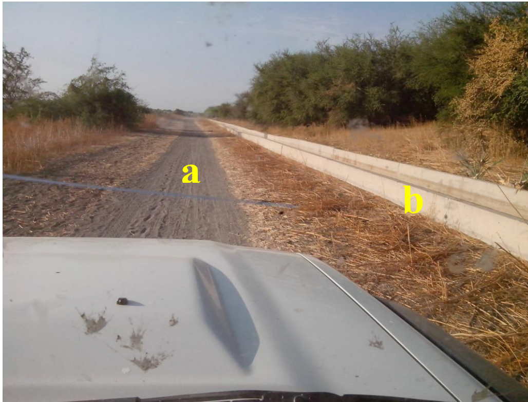
Au premier plan (a), la route longeant le polder, et à gauche (b), un ouvrage d'irrigation formé d'un canal en béton en forme de U.
