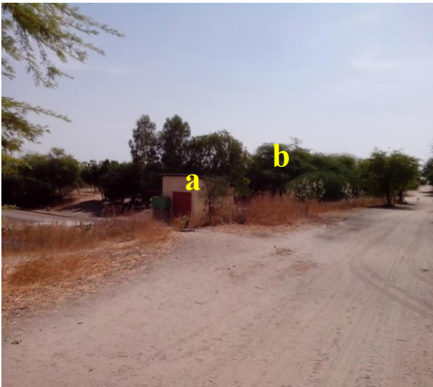
Au premier plan (a), une station de pompage pour l'irrigation du polder. En arrière-plan (b), des acacias colonisant la digue isolant le polder du lac.
