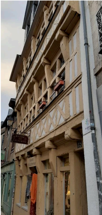
Photographie d'un habitat en pan de bois avec encorbellements dans la rue Saint-Malo à Rennes. Photographie réalisée par Victor Villain en 2019.
