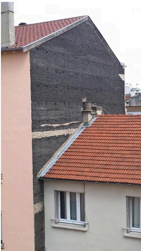
Photographie prise dans le 7<sup>e</sup> arrondissement de Lyon au 121 rue Sébastien Gryphe en direction du Nord-Est. Vue sur un immeuble de 7 étages situé au 36 rue Chevreul et dont le mur pignon est construit en pisé de mâchefer. Photographie réalisée par Victor Villain en 2018.
