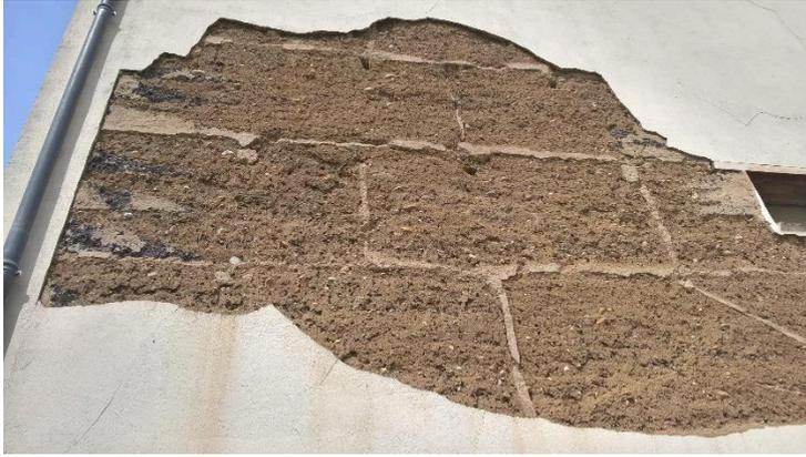
Photographie d'un mur porteur en pisé de terre perceptible du fait de l'érosion d'un enduit sur le mur d'une façade exposée Sud d'un bâtiment situé rue Bataille, dans le 8<sup>ème</sup> arrondissement de Lyon. Photographie réalisée par Victor Villain en 2018.
