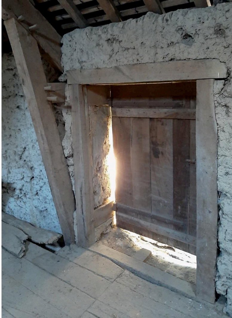
Photographie d'une carrée double dans un mur en bauge au premier étage et à l'intérieur d'une dépendance d'une maison datant du XIX ème en Bretagne où était stocké des récoltes céréalières. Photographie réalisée par Victor Villain en 2019.
