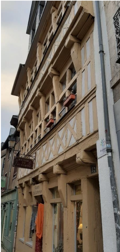
Photographie d'un habitat en pan de bois avec encorbellements dans la rue Saint-Malo à Rennes. Photographie réalisée par Victor Villain en 2019.
