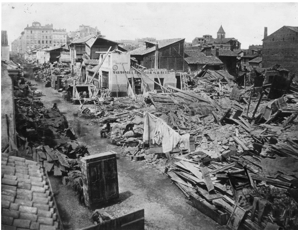
Photographie de Louis FROISSART. Rue Madame (actuelle Rue Pierre Corneille) en juin 1856 après l'inondation, vue en direction du Nord. Source : Archives de la Bibliothèque municipale de Lyon. Cote : P0546 S 0109.
