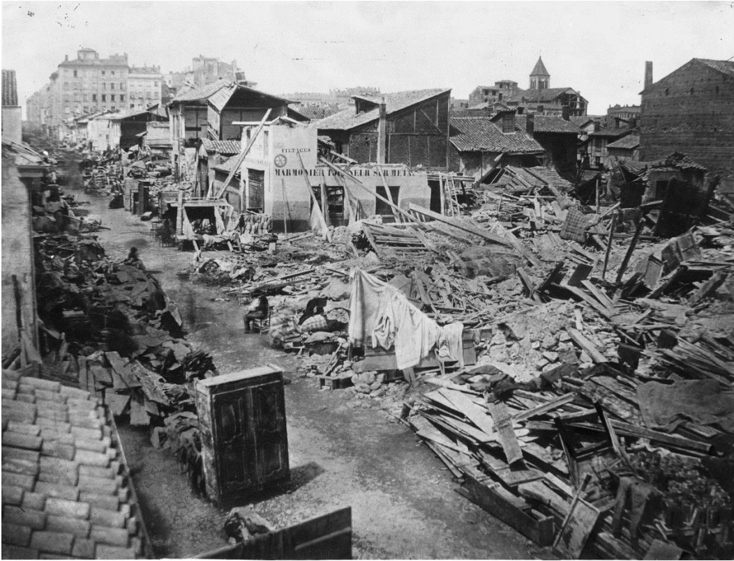
Photographie de Louis FROISSART. Rue Madame (actuelle Rue Pierre Corneille) en juin 1856 après l'inondation, vue en direction du Nord.
