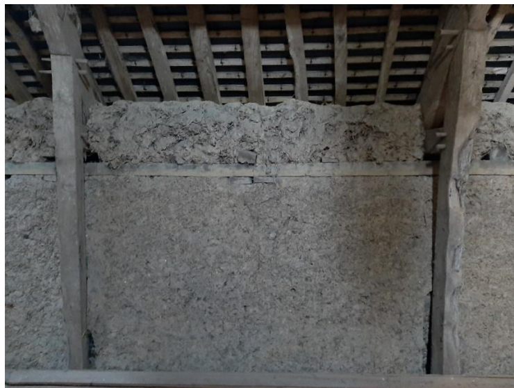
Photographie d'une charpente engagée dans un mur porteur en bauge au premier étage et à l'intérieur d'une dépendance d'une maison datant du XIXème en Bretagne. Photographie réalisée par Victor Villain en 2019.
