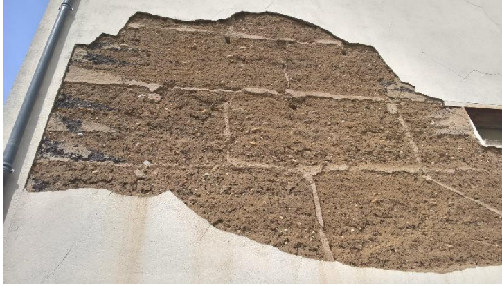
Photographie d'un mur porteur en pisé de terre perceptible du fait de l'érosion d'un enduit sur le mur d'une façade exposée Sud d'un bâtiment situé rue Bataille, dans le 8 ème arrondissement de Lyon. Photographie réalisée par Victor Villain en 2018.
