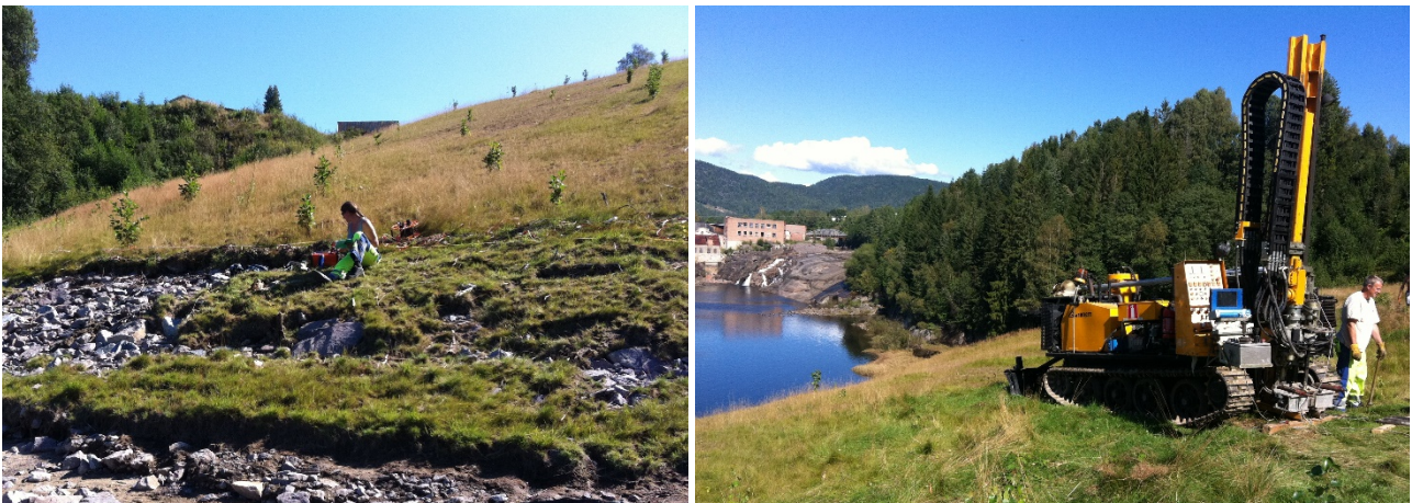
Figure 10: Campagne de géophysique de proche surface (ERT, GPR et sismique) et sondages géotechniques pour caractériser une pente présentant un fort aléa de glissement de terrain à cause de la présence d'une épaisse couche d'argile sensible en bordure de rivière, à Hvitvingfoss en Norvège.
