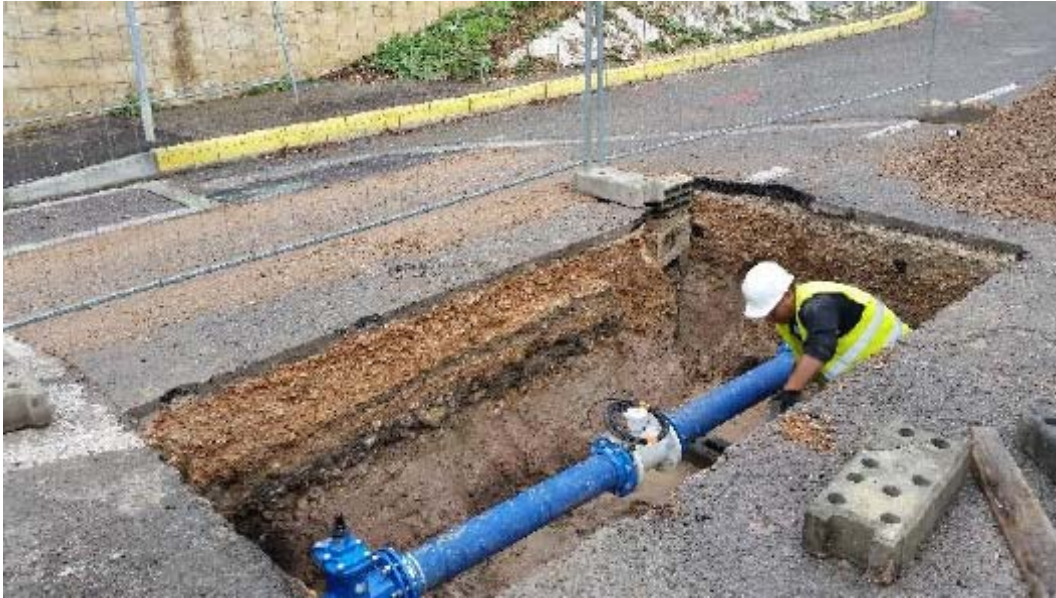
Photo 3 : Travaux de pose d'un compteur de sectorisation à Grabels
