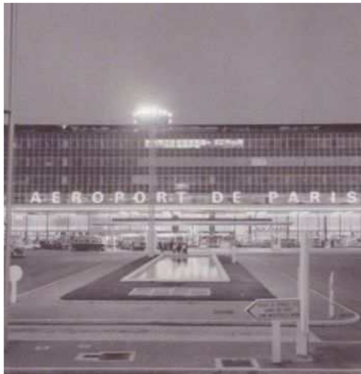
III.4.13. Orly, Aérogare d'Orly Sud, 1961, Architectes Henri Vicariot et Aéroport de Paris, Source Archives Aéroports de Paris
