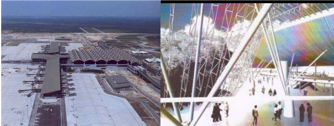
III.7.2.2. Aéroport de Kuala Lumpur, A gauche, vue aérienne du complexe aérogare, Source Cuadra (Manuel), World Airports , Hamburg, Deutsches Architektur Museum, Junius Verlag et Dam, 2002, p56 ; A droite, Vue perspective de l'intérieur, Source Powell (Kenneth), La ville de demain , Seuil 2000, pp142-149
