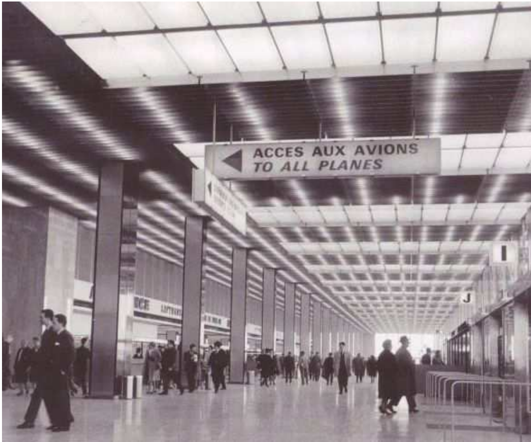
III.5.8.2 L'aérogare d'Orly Sud, ca 1961-1962
