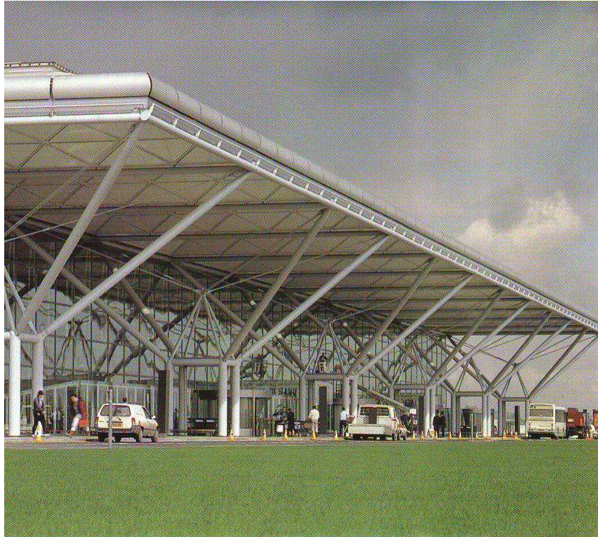
III.7.12.1. Aéroport de Stansted, Londres, Architecte Norman Foster
