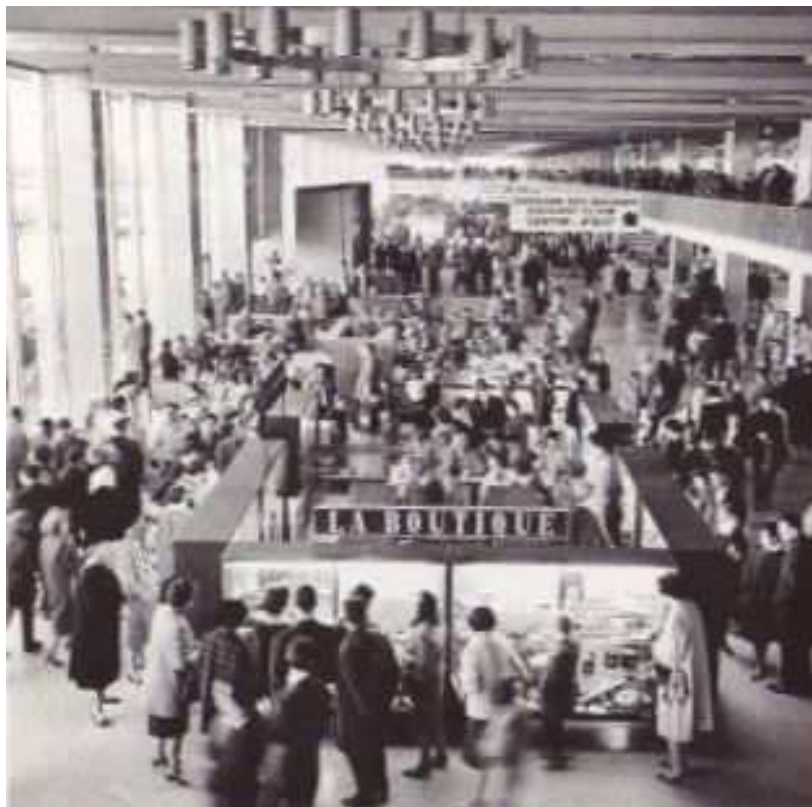
III.5.8.2 L'aérogare d'Orly Sud, ca 1961-1962
