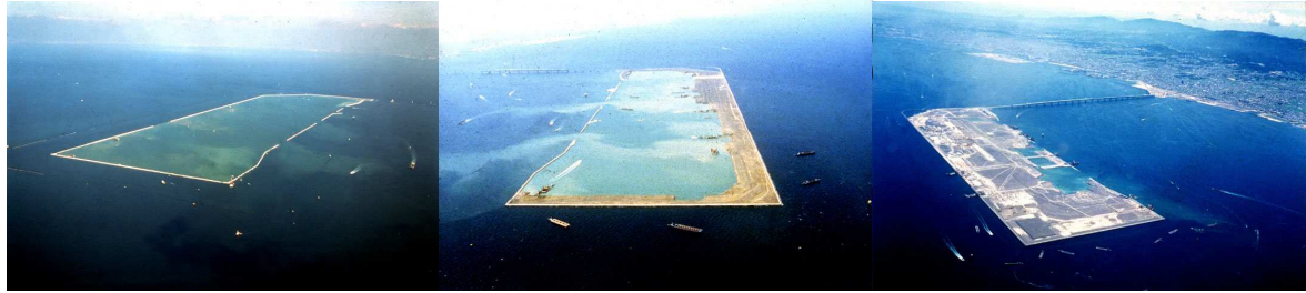
III.7.5. Aéroport du Kansai, « 3 vues de l'île artificielle de 511 hectares durant son édification, sur laquelle fut construit le bâtiment du terminal de l'Aéroport international de Kansai », Source Okabe (Noriaki), « L'émergence de l'espace, le bâtiment du terminal de l'aéroport international de Kansai », UTLS, 28 Octobre 2004
