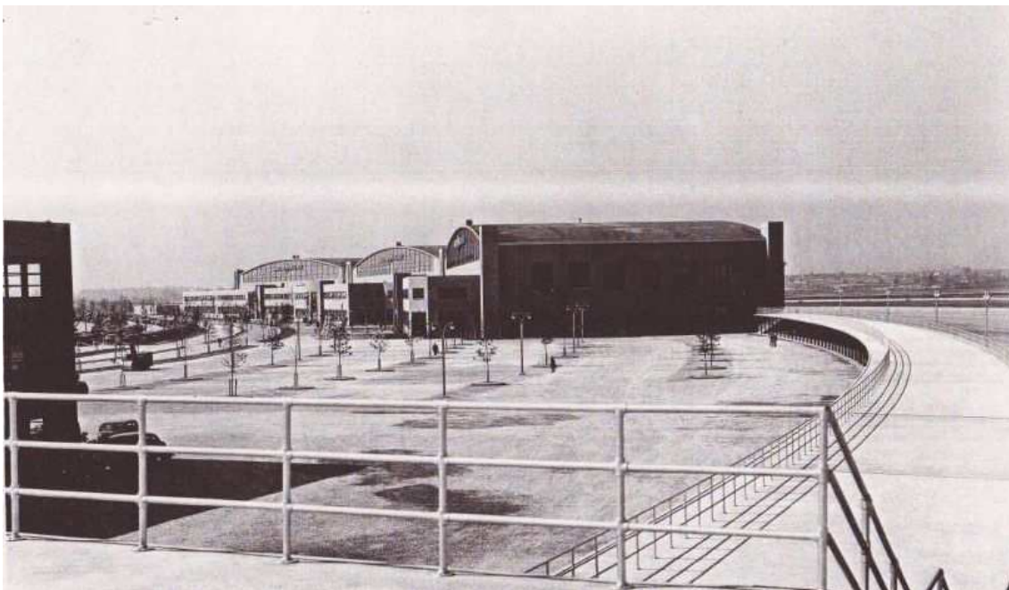
III.3.10.3. Aéroport LaGuardia, 1940, Vue sur les hangars à avions, et la terrasse-promenade au premier plan, Sources Archives Delano et Aldrich, Avery Architectural and Fine Arts Library, Columbia University, New York
