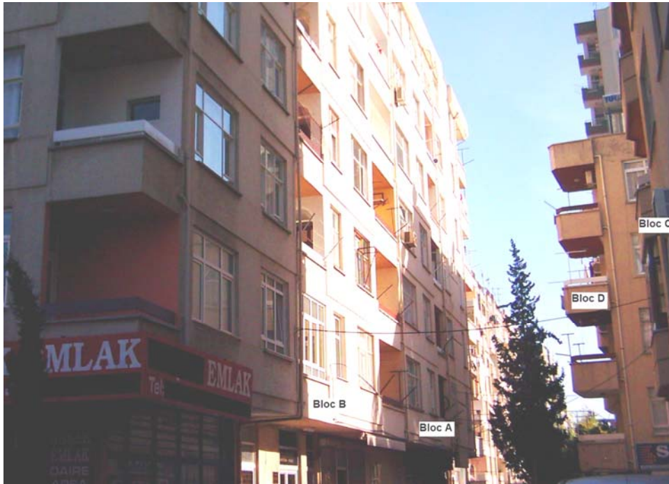
Figure 6 : Les différents immeubles de l'étude
