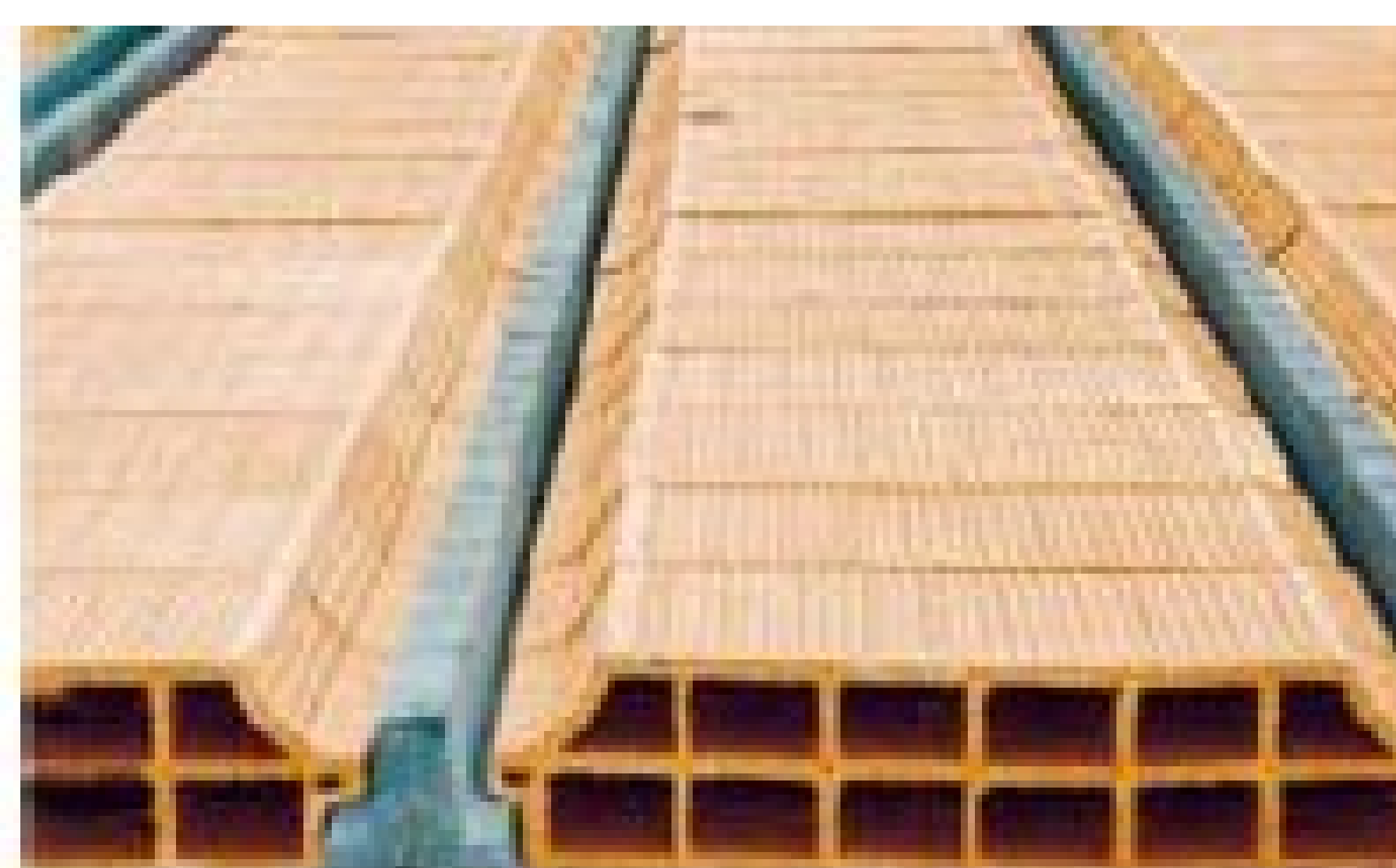
Figure 29 : Plancher avec hourdis en terre cuite.
