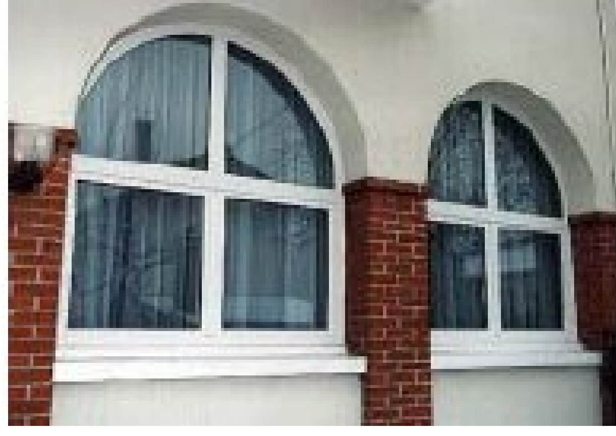
Figure 48: Ouvertures avec châssis en aluminium.
