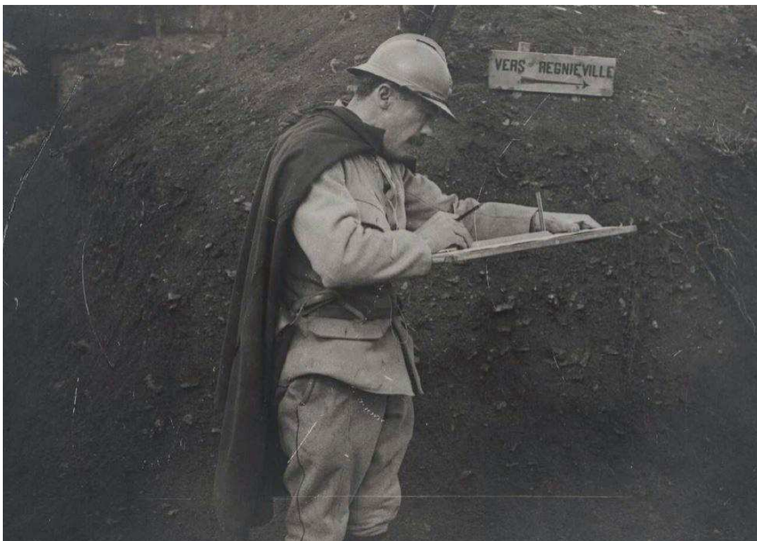
Fig.1.7: Réalisation d'un relevé topographique avec une planchette topographique près de Regniéville-en-Haye en Avril 1917 (Source : BDIC VAL 167/018)
