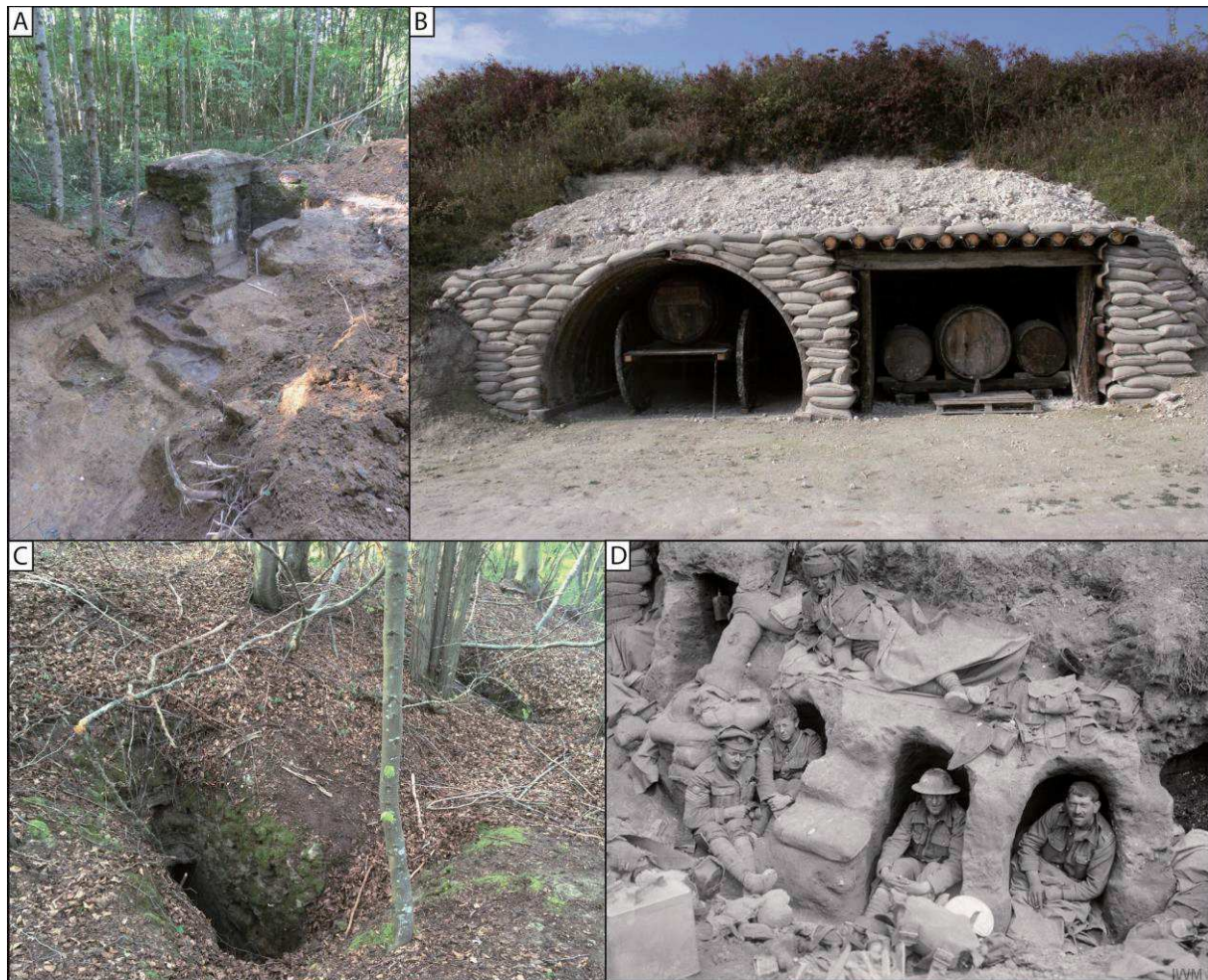
Fig.6. 32: A – Poste de guetteur bétonné en forêt d’Argonne (Cliché : Taborelli P.) B – Reconstitution d’abris superficiels sur le site de la Main de Massige (Cliché : Devos A.). C – Entrée double d’un abri-caverne (Cliché : Taborelli P.). D – Abri de type niche (Source : Cliché IWM).
