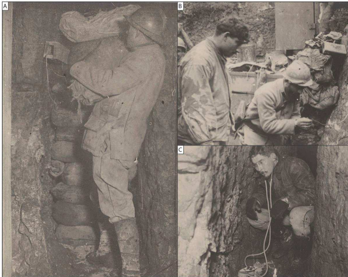
Fig.6. 5: A – Bourrage par sacs à terre d'un fourneau de mine en Argonne (Source : BDIC VAL 113/103). B – Allumage de la mèche lente du fourneau en Argonne (Source : BDIC VAL 113/104). C – Ecoute des travaux de mines de l'ennemi par un officier du génie en Argonne (Source : BDIC VAL 113/099).
