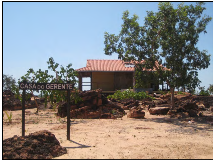
Photo 21: Nous avons passé deux nuits dans la "casa do gerente" (maison du gérant), à l'entrée de la RDS Veredas do Acari
